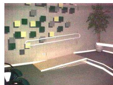
Imagem XLVI – Rampa de Acesso – USP Campus de Ribeirão Preto
