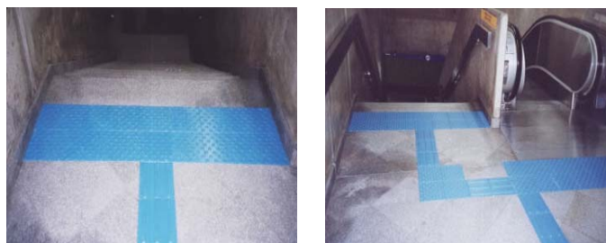
Imagens LXXV e LXXVI – Piso Tátil, Metrô Estação São Judas, São Paulo
