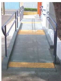
Imagem LV – Instalação de Corrimãos e Piso com Sinalização Tátil de Alerta em Cores Contrastantes USP, Campus de São Carlos
