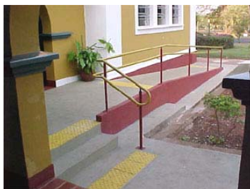
Imagem LIX – Escada acessível – USP, Campus de Ribeirão Preto.
