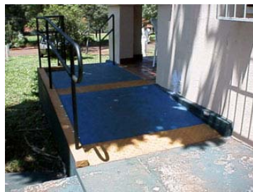
Imagem XLIII – Rampa de Acesso – USP Campus de Pirassununga
