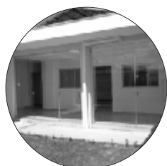
ITAPIRA Rua João de Moraes, 449 EM ANDAMENTO
