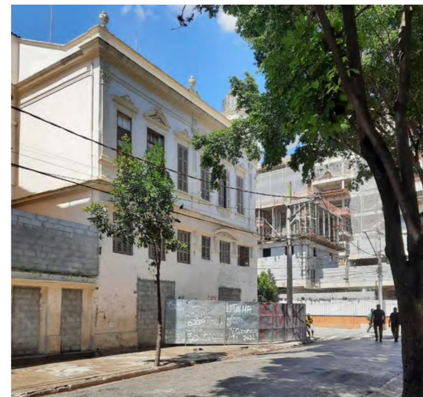
Figura 2 - Interdição de imóveis na Quadra 37 da ZEIS 3, de Campos Elíseos, em São Paulo, e construção do Hospital Pérola Byington, ao fundo, na Quadra 36 da mesma ZEIS. Março de 2021.
