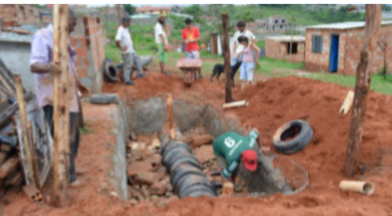
Figura 06: Construção do Tanque de Evapotranspiração - TVAP Fonte: Acervo da Equipe de Comunicação do MLB, 2012
