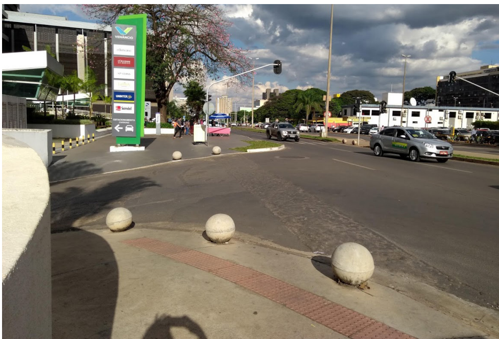
Fig. 2: Cruzamentos inclinados, sem faixa de pedestres, com obstáculos e sem marcação correta de piso tátil é inseguro para todos e em especial para pessoas com deficiência visual ou com deficiência motora. Fonte: Acervo pessoal de Marta Dischinger.
