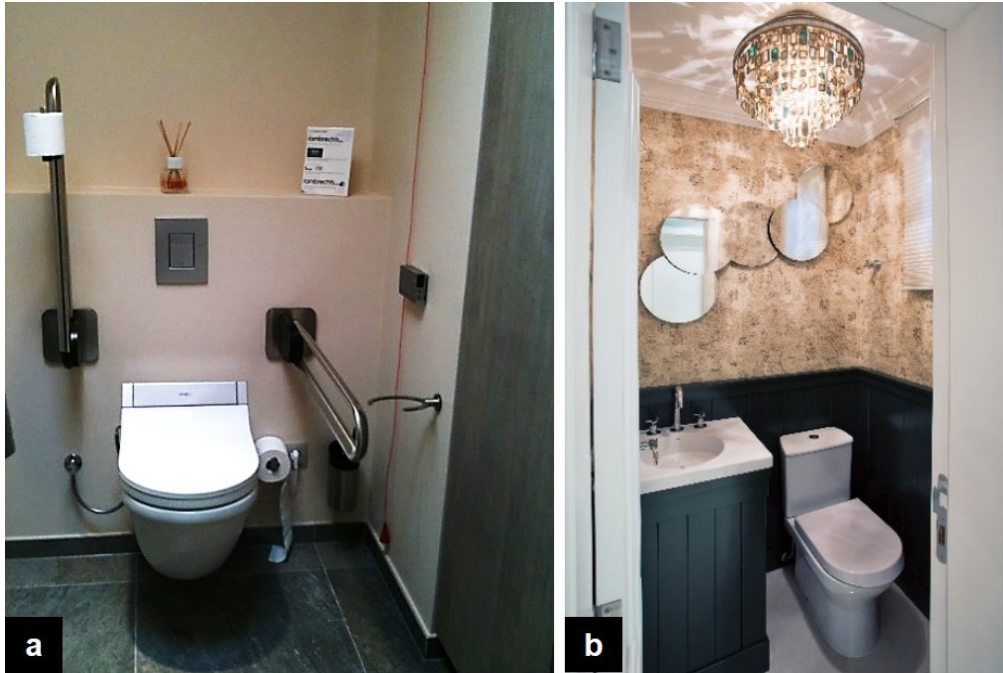
Fig. 19: Sanitário em casa acessível na Bélgica (a), e lavabo projetado pelo arquiteto Thiago Mondini (b) possuem contraste de cor entre os equipamentos, paredes e pisos permitem a pessoas com baixa visão perceber os limites do espaço e identificar os equipamentos para seu uso.
