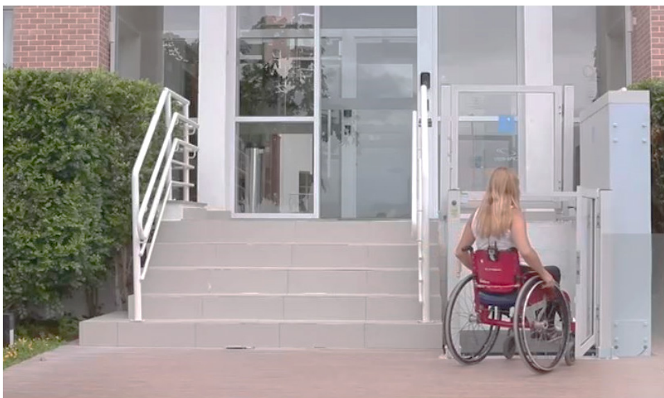
Fig. 8: Plataformas elevatórias e elevadores permitem o acesso a pavimentos superiores para pessoas em cadeira de rodas e com mobilidade reduzida.
