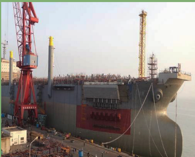
Figura 15 – FPSO Cidade de Ilhabela em construção. Fonte: PETROBRAS
