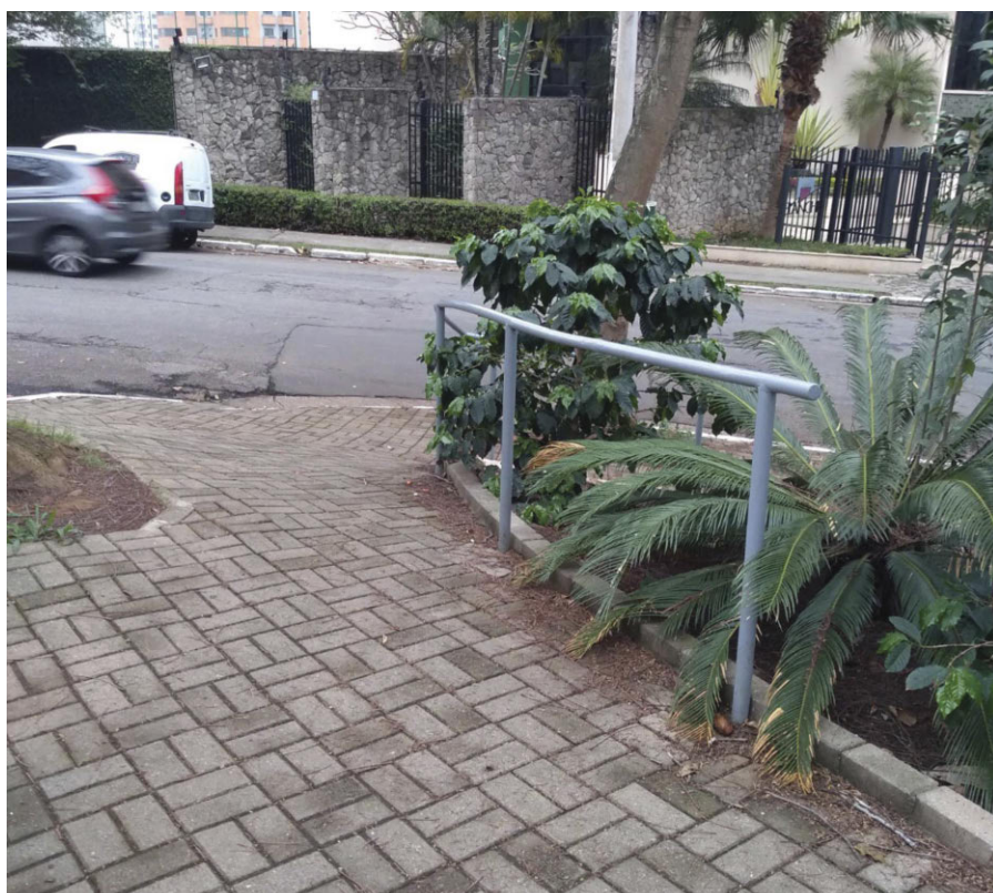
Figura 13 Fotografias de calçadas opostas, localizadas na mesma rua. Na imagem A, a calçada tem degraus que dificultam a caminhada. Na imagem B, a calçada foi nivelada em rampas para compatibilizar inclinações longitudinais e transversais.
