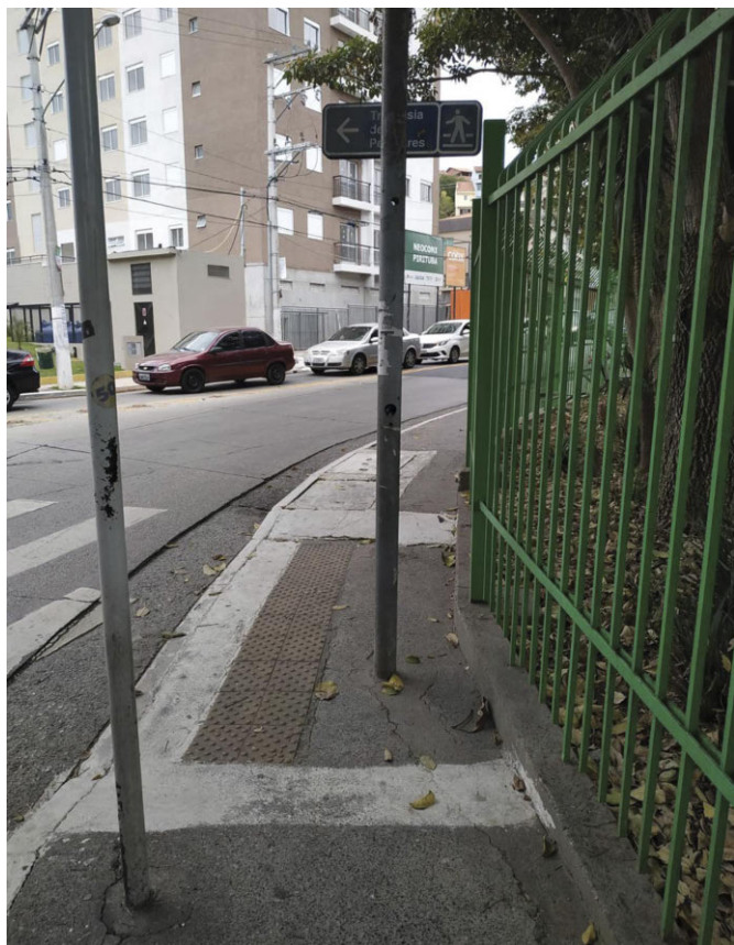
Figura 49 Exemplo de incompatibilidade e sobreposição de elementos no espaço urbano, com poste de serviço presente no meio da rampa de acesso, que fica impossibilitada ser utilizada.
