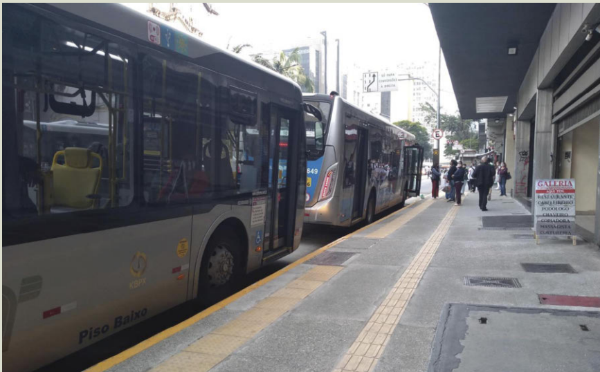
Figura 24 Exemplo de calçada elevada para embarque e desembarque em nível com o piso dos ônibus.
