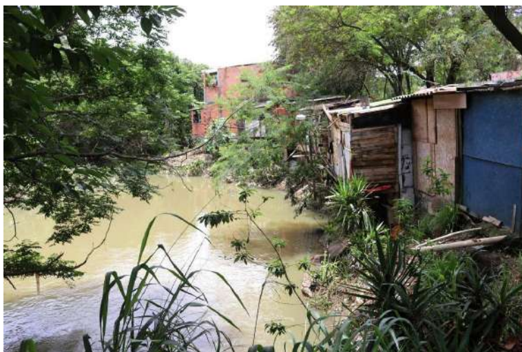
Figura 29 – Domicílios do Jardim Keralux construídos na encosta da várzea do Rio Tietê, pós chuva
