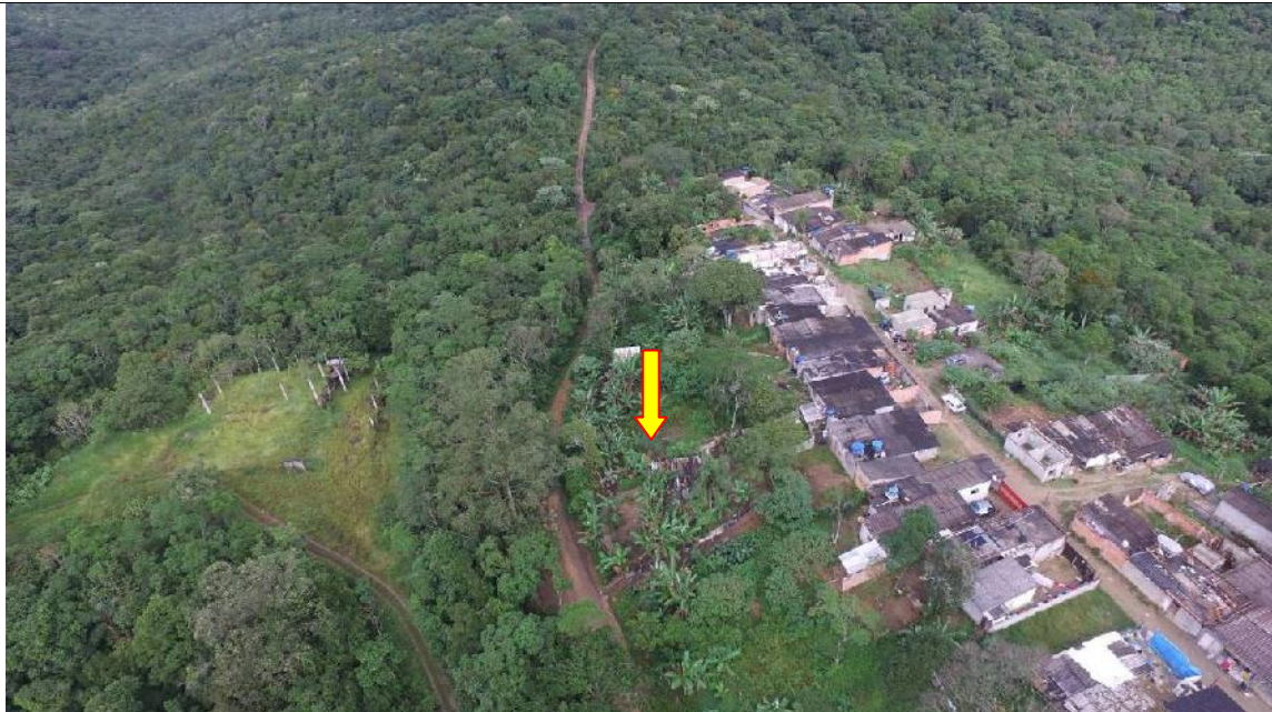
Foto 1 – A área A.1 indicada pela seta amarela sofreu supressão da vegetação nativa (Floresta Ombrófila Densa, estágio avançado) e, atualmente, abriga edificações precárias, bem como plantios de frutíferas.
