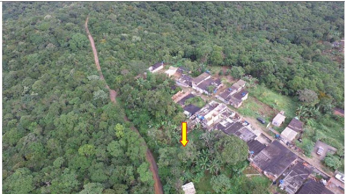
Foto 2 – A área A.1 indicada pela seta amarela sofreu supressão da vegetação nativa (Floresta Ombrófila Densa, estágio avançado) e, atualmente, abriga edificações precárias, bem como plantios de frutíferas.
