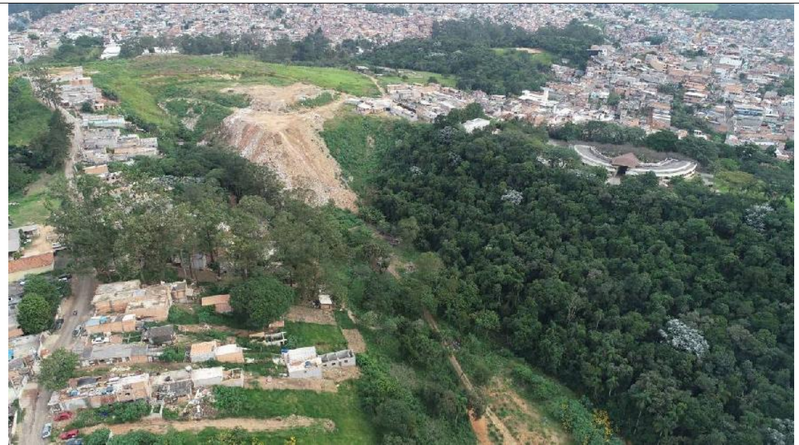
Foto 16 – Em primeiro plano, na foto, ocupação por habitações em área onde havia floresta nativa parcialmente na APP de curso d'água. Mais em segundo plano, depósito de resíduos clandestino executado sobre APP da nascente do curso d'água que até janeiro/2014 era recoberta por vegetação florestal estágio avançado.
