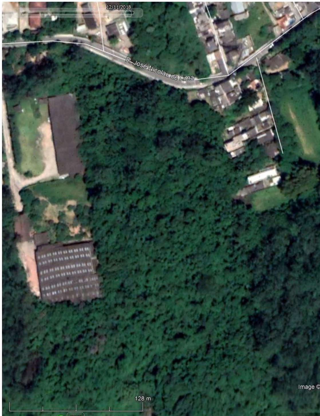
Figura 24 – Início de intervenção a ser notada na porção superior da imagem – Imagem Google Earth ® de 11/12/2018.
