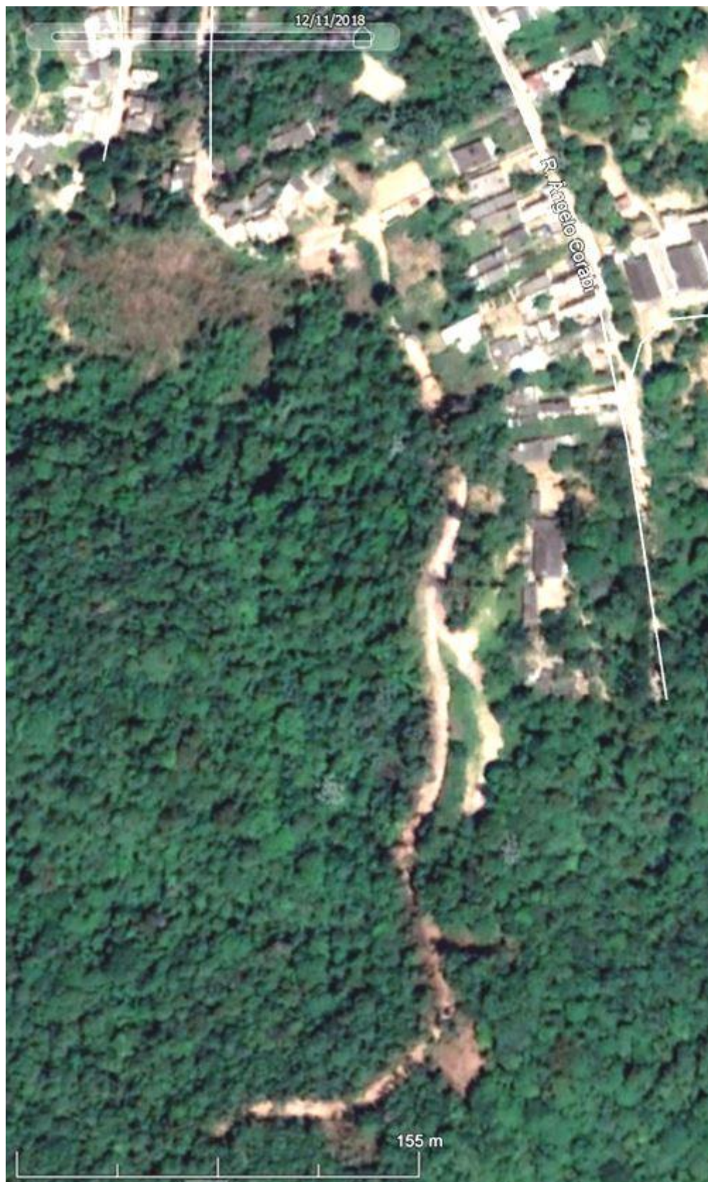
Figura 16 – Ocorrência de supressão da vegetação florestal para abertura de arruamento e lotes - Imagem Google Earth ® de 11/12/2018.
