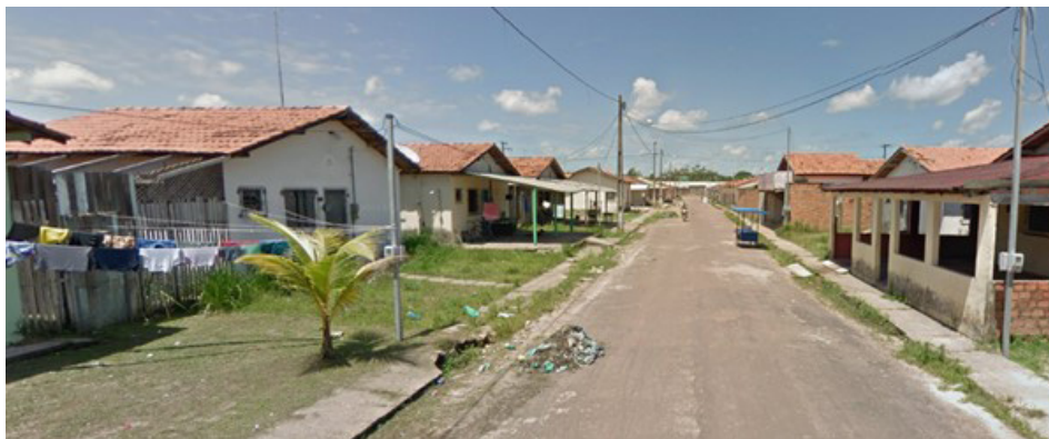
Figura 1. Empreendimento habitacional do PMCMV em Igarapé-Miri (PA), ago. 2019.
