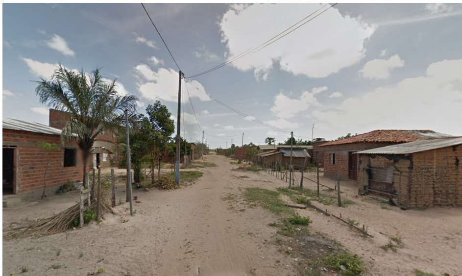
FIGURA 8: Ausência de iluminação pública e habitações sem acesso a energia elétrica no entorno do Residencial Silvia Catanhede I, Paço do Lumiar (MA) – nov. 2011
