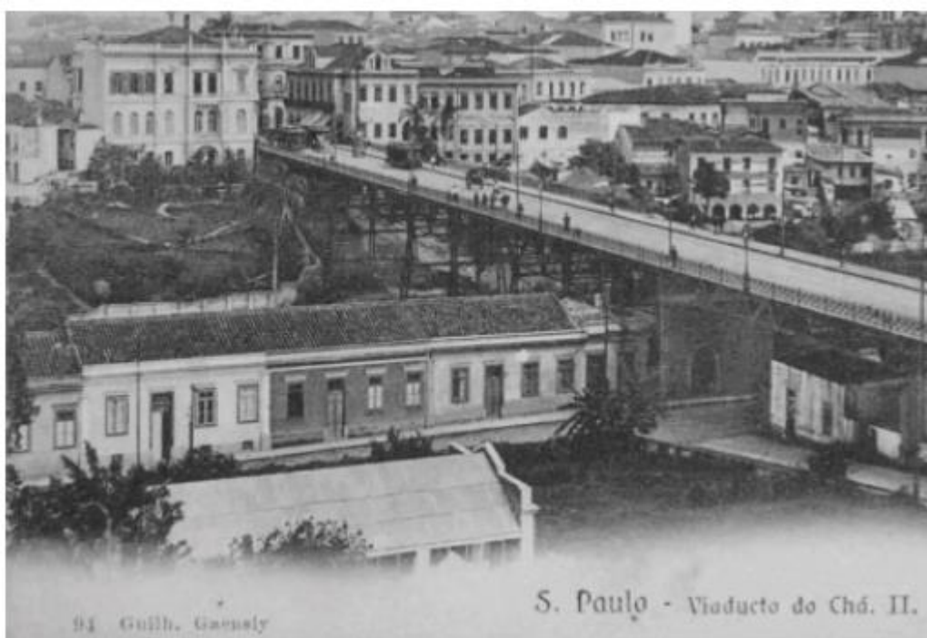
Figura 2.19: Viaducto do Chá II. Cartão postal de Guilherme Gaensly s/d. No canto esquerdo da foto, observar o casarão do Barão de Tatuí/Conde Prates (Ramos de Azevedo, 1896). Veja que o quintal do mesmo se estende até o fundo do vale. Em primeiro plano, as casinhas de aluguel da Rua Formosa, também de propriedade do Conde Prates. Fonte: Álbum de postais da cidade de São Paulo (1900-1940). Acervo BMA. Reproduzido de D’Elboux, 2015, p. 288.
