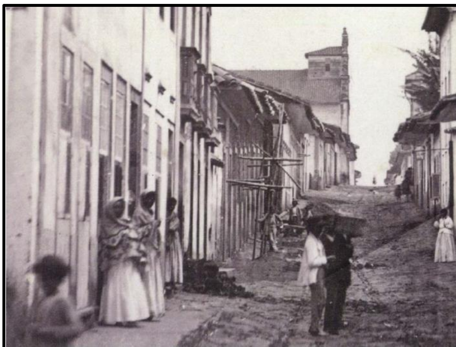
Figura 2.22: Antiga Rua do Quartel, em 1860 . Foto de Militão A, de Azevedo. Tradicional reduto dos negros em São Paulo. Foto tomada em direção ao Largo da Cadeia, atual Praça João Mendes. No alto, a igreja de N. Sra. Dos Remédios, demolida. Essa rua desapareceu para a construção da Praça da Sé. Reproduzido de Camargo, 2007, p. 242.
