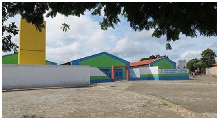
Figura 11 – Fachada da escola
