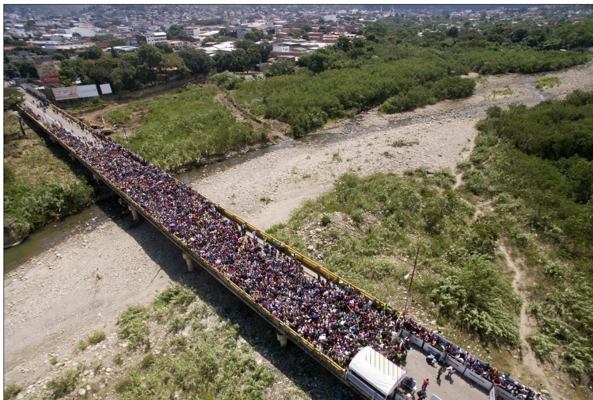
Fotografia 1 - Ponte Simón Bolívar.
