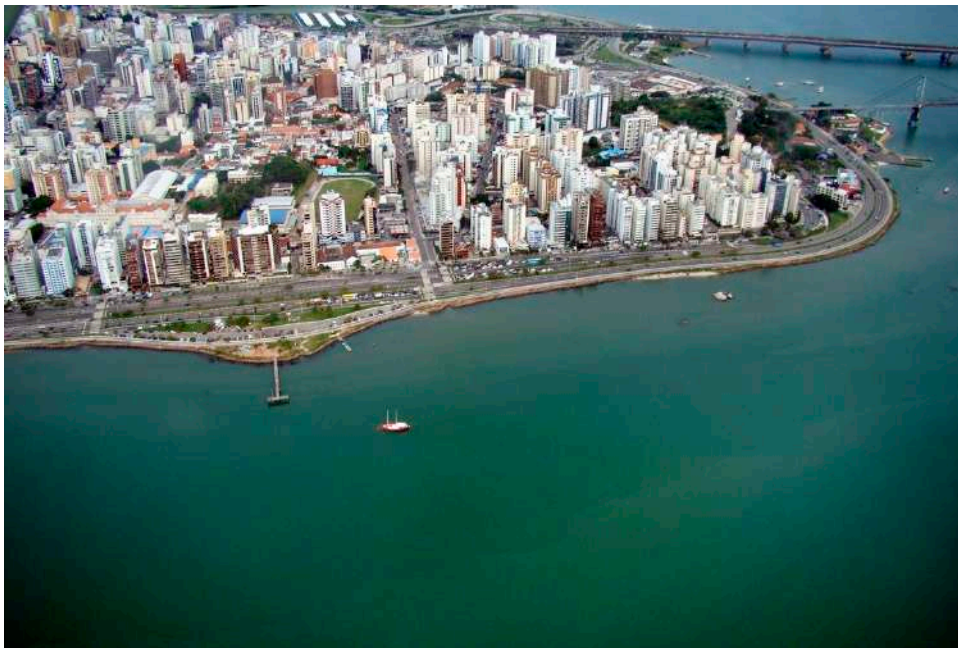
Figura 8.18 – Barreira de prédios no aterro da Baía Norte, Florianópolis (SC).
