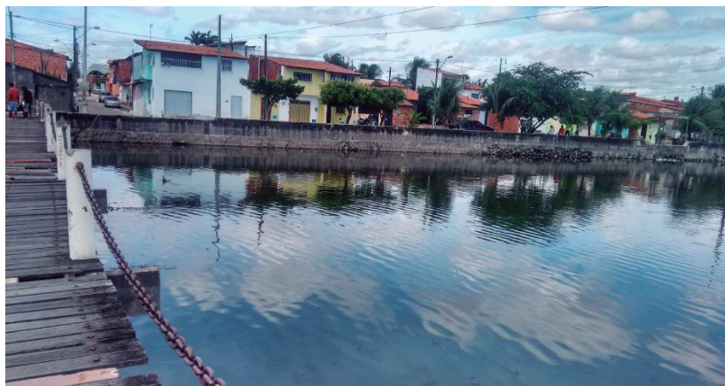
Figura 17 – Comunidade do Lagamar, vista de ponto sobre o Canal do Tauape Fonte: Acervo Ruy Rolim (2016)
