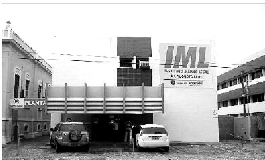
Foto 5 – Prédio do IML/SE
