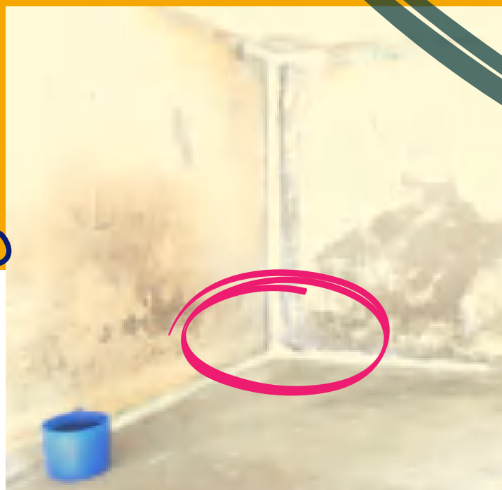
Foto 33/34 – CDP Masculino de Caraguatatuba – 05/03/2021 – Celas com infiltração de água.
