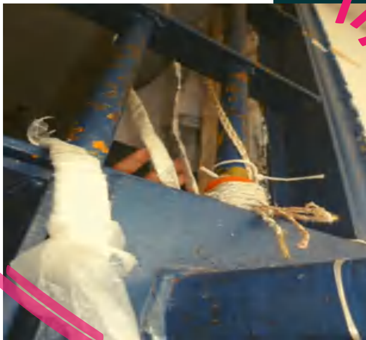
Foto 19 – CDP Masculino de Vila Independência – 11/6/21 – “fiação” feita artesanalmente com tampas das marmitas.
