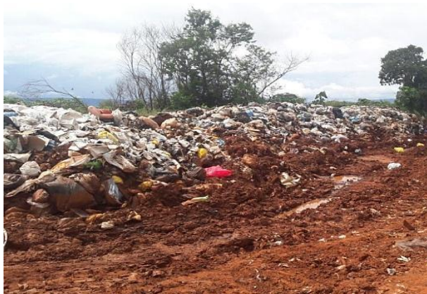
Figura 8 – Disposição final de resíduos inadequada.
