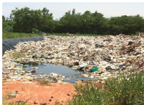
Figura 9 – Lixão com acúmulo de chorume
