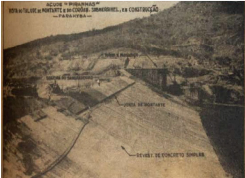
Figura 4 - Estrutura do açude “Engenheiro Avidos” no Rio Piranhas na sua fundação (1936)
