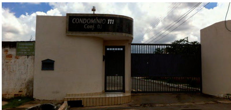
Figura 7. Captou a entrada de um condomínio irregular formada na localidade. Tirada em 04.04.2014.
