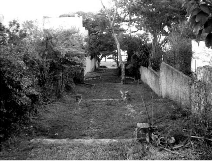
Foto 3 – Passagem de pedestres objeto do estudo de caso, vista de outro ângulo, antes da alienação do bem público. Observe-se a precarização da conservação do bem (ausência de capina e de iluminação pública) em período imediatamente anterior ao bem ser alienado e fechado ao uso público.
