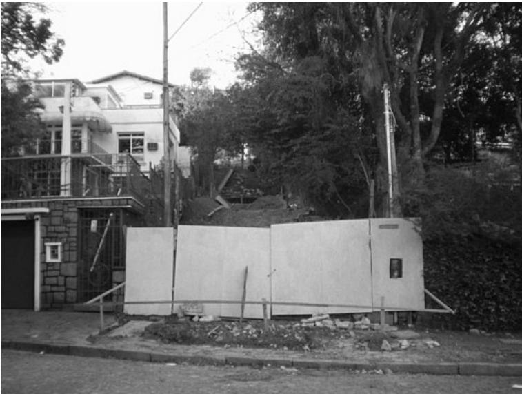
Foto 4 – Antiga escadaria e passagem de pedestres já alienada, fechada ao uso público, privatizada e transformada em canteiro de obras pelo novo proprietário.
