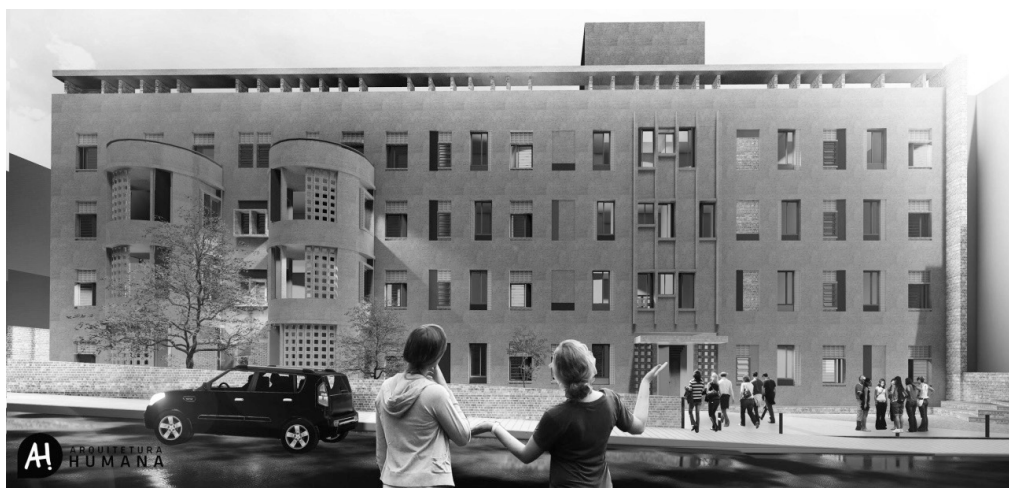
Imagem 01 - Projeto arquitetônico de autoria do escritório “Ah! Arquitetura Humana” para o prédio que está ocupado pela Cooperativa 20 de Novembro, a partir da escuta de seus/suas moradores/as. Ele está localizado em Porto Alegre, na Rua Barros Cassal, esquina com a Avenida Farrapos. Fonte: Escritório “Ah! Arquitetura Humana”.
