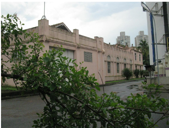
Figura 21. Estação de tratamento de esgoto
