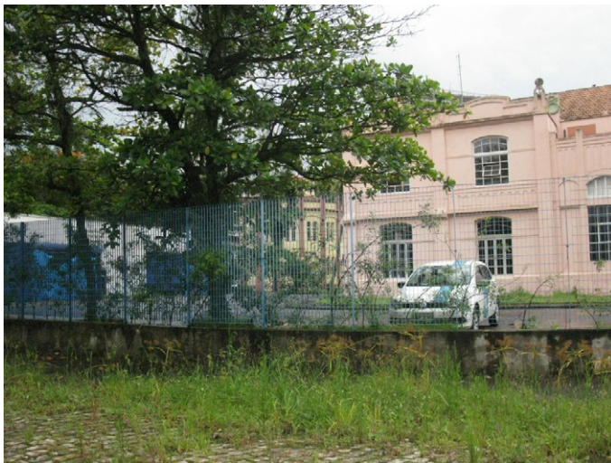
Figura 22. Estação de tratamento de esgoto
