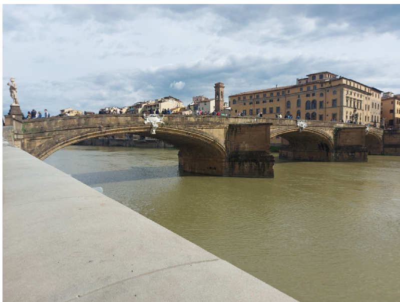
Figura.2. Ponte da Trindade (1567-1569) – Florença. Projeto Bartolomeu Ammanati.
