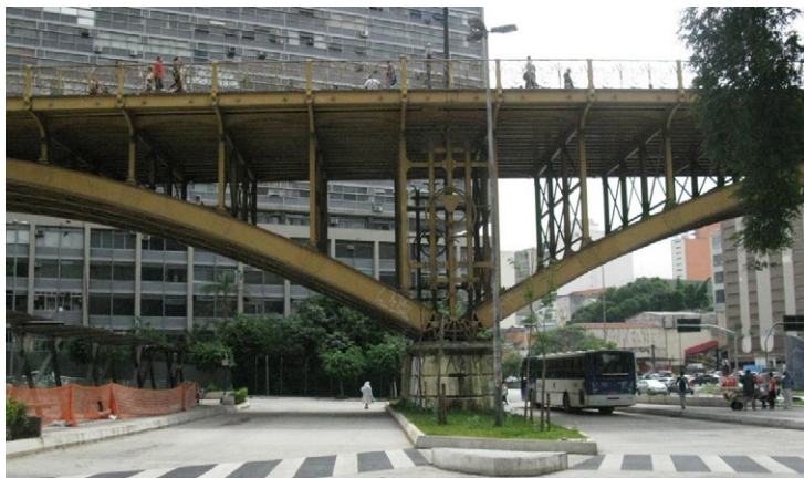
Figura 3. Viaduto de Sta. Ephigenia
