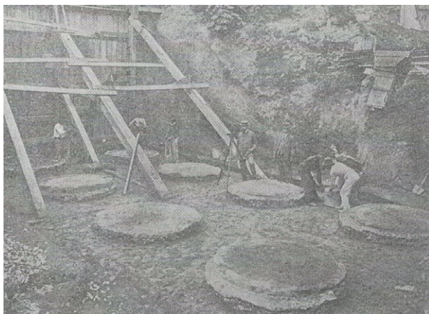
Figura 8. Viaduto de Sta.Ephigenia. Poços de Concreto no encontro de São Bento.
