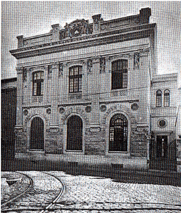
Figura 4. Edifício da caixa econômica de São Paulo. Eng.arquiteto Ramos de Azevedo e Domiziano Rossi.
