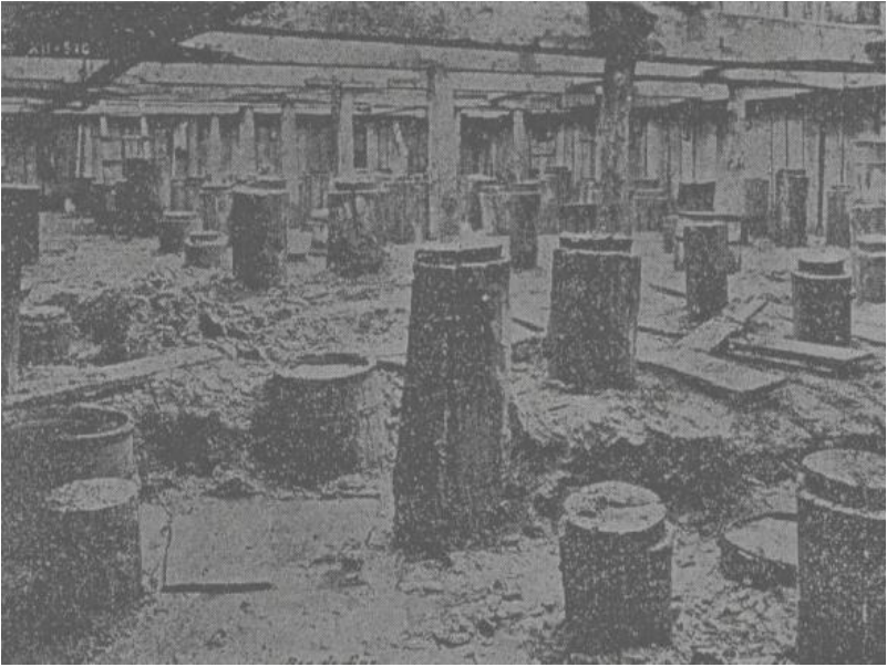
Figura 7. Viaduto de Sta.Ephigenia Estacas de fundação
