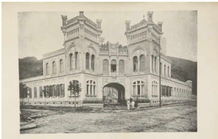
Figura 6. Corpo de Bombeiros de Santos. Eng.arquitetoMax Hehl.
