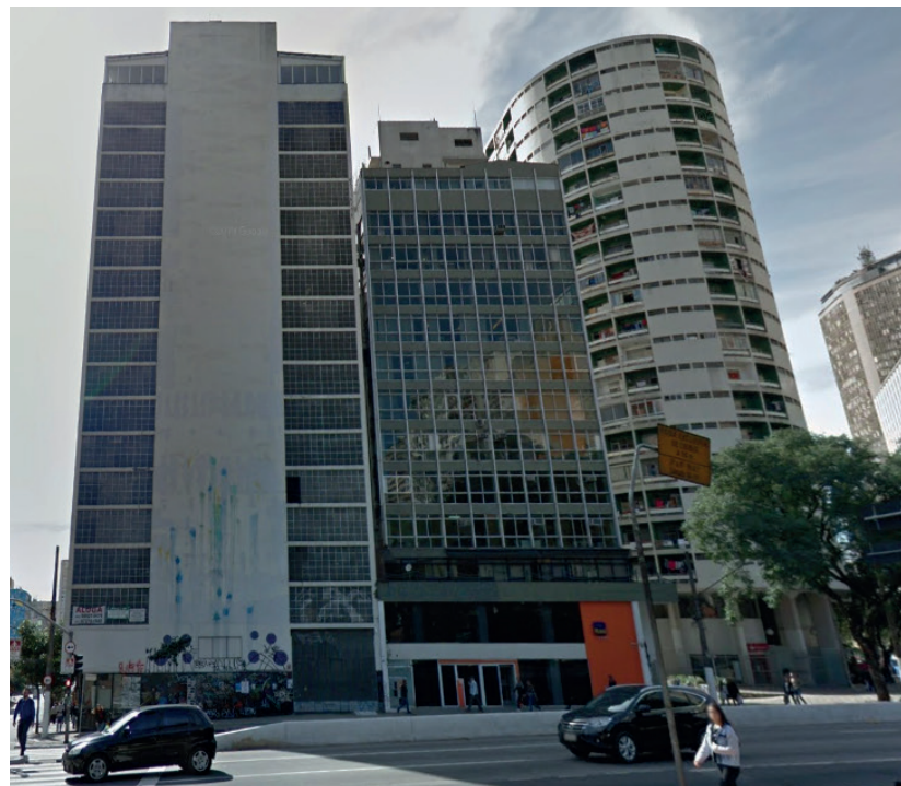
FIGURAS 6 e 7 Imóveis NU “condominiais” notificados: edifício de escritórios na Av. São João e edifício garagem na Rua Rego Freitas
