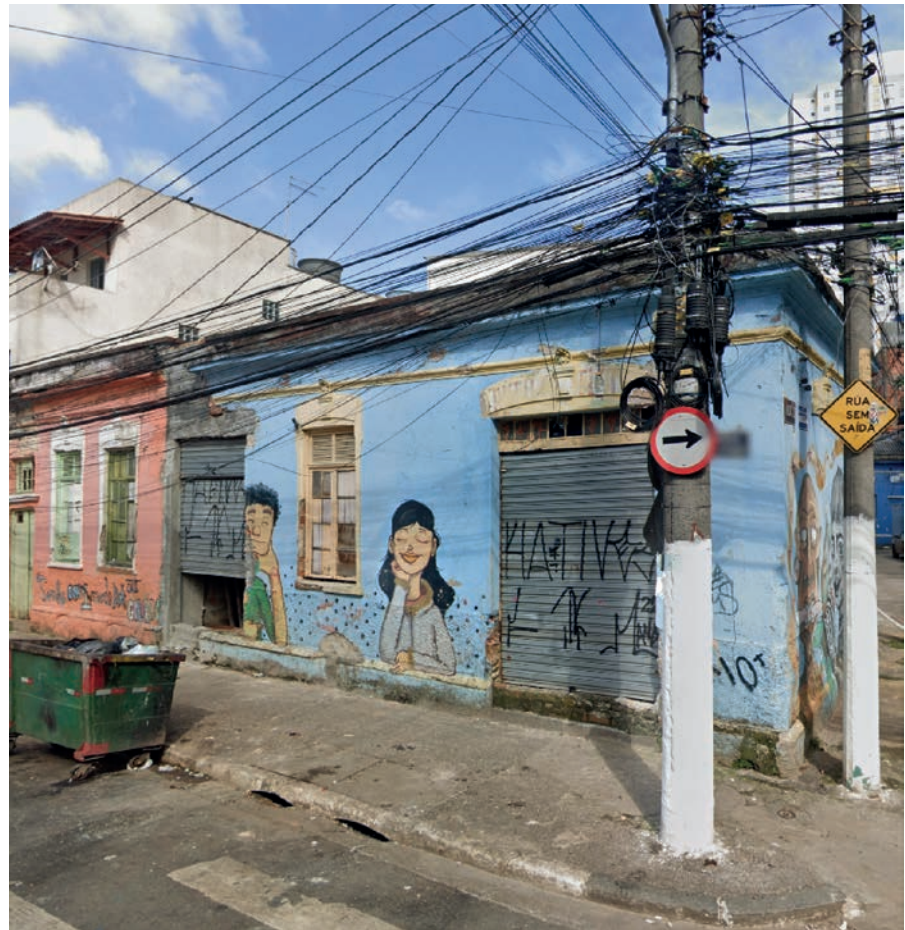
FIGURA 5 Imóvel potencialmente Não Utilizado com acessos lacrados (NU0097).
