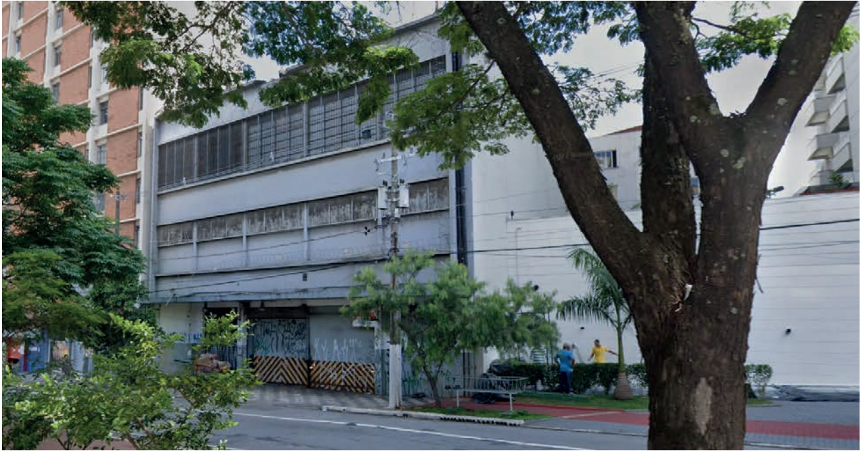
FIGURA 11 Imóvel potencialmente NU, tipologia de edificação “Térreo + Sobreloja/Mezanino” (Santa Cecília)
