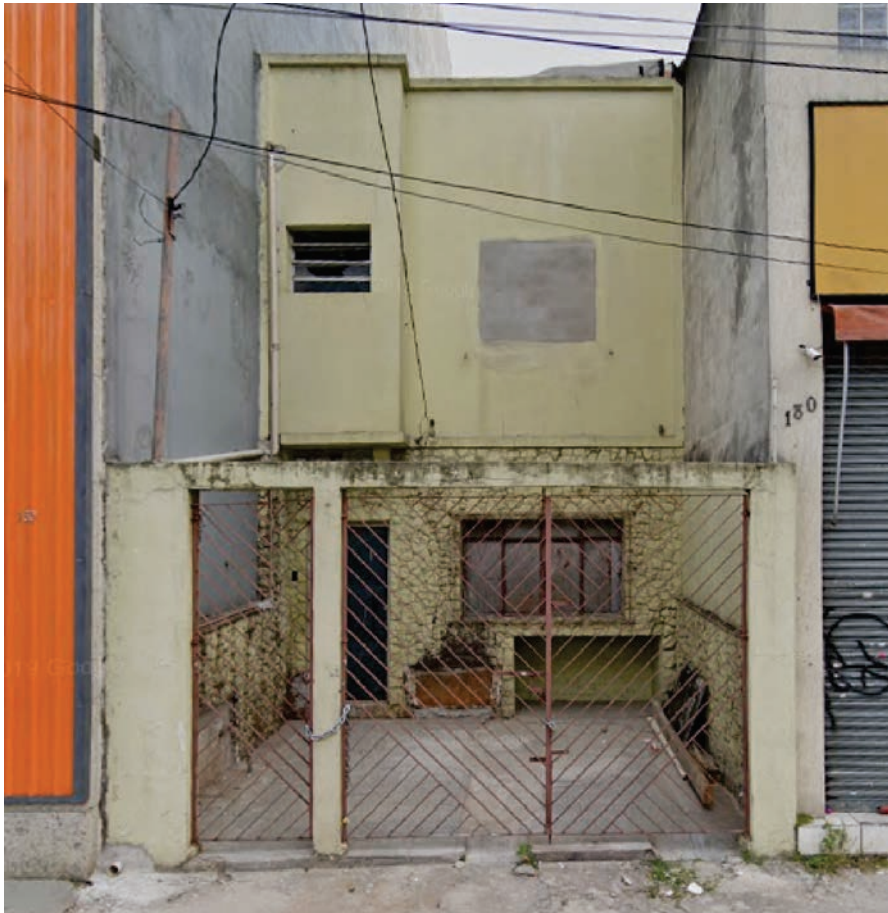
FIGURA 6 Imóvel potencialmente Não Utilizado com janelas quebradas, lacradas ou com fechamento provisório (NU0341).
