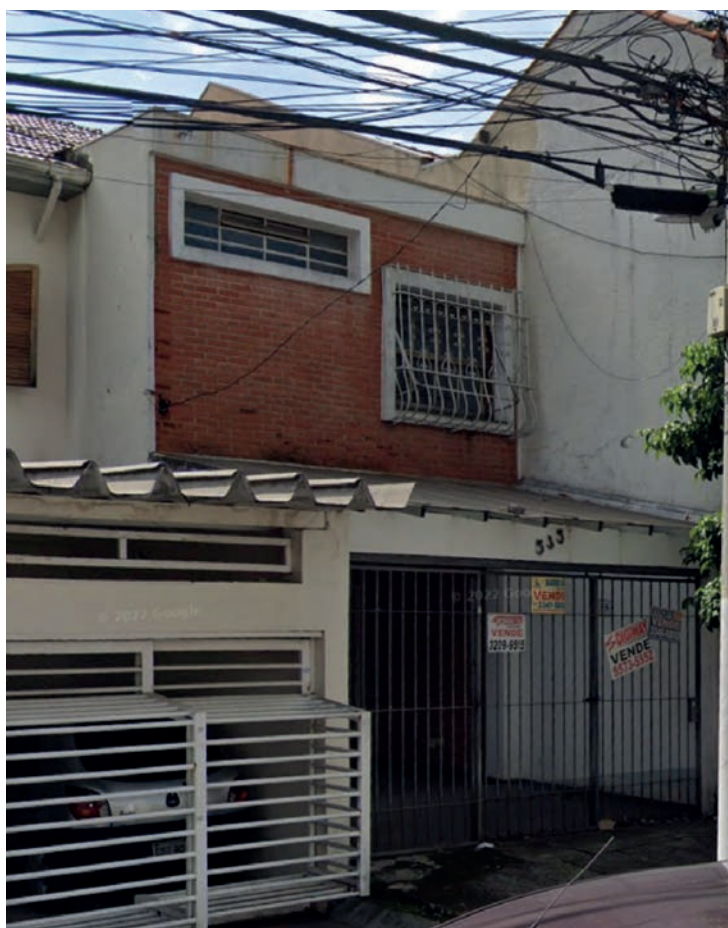
FIGURA 1 Imóvel potencialmente Não Utilizado na tipologia de edificação predominante do distrito (NU0974).
