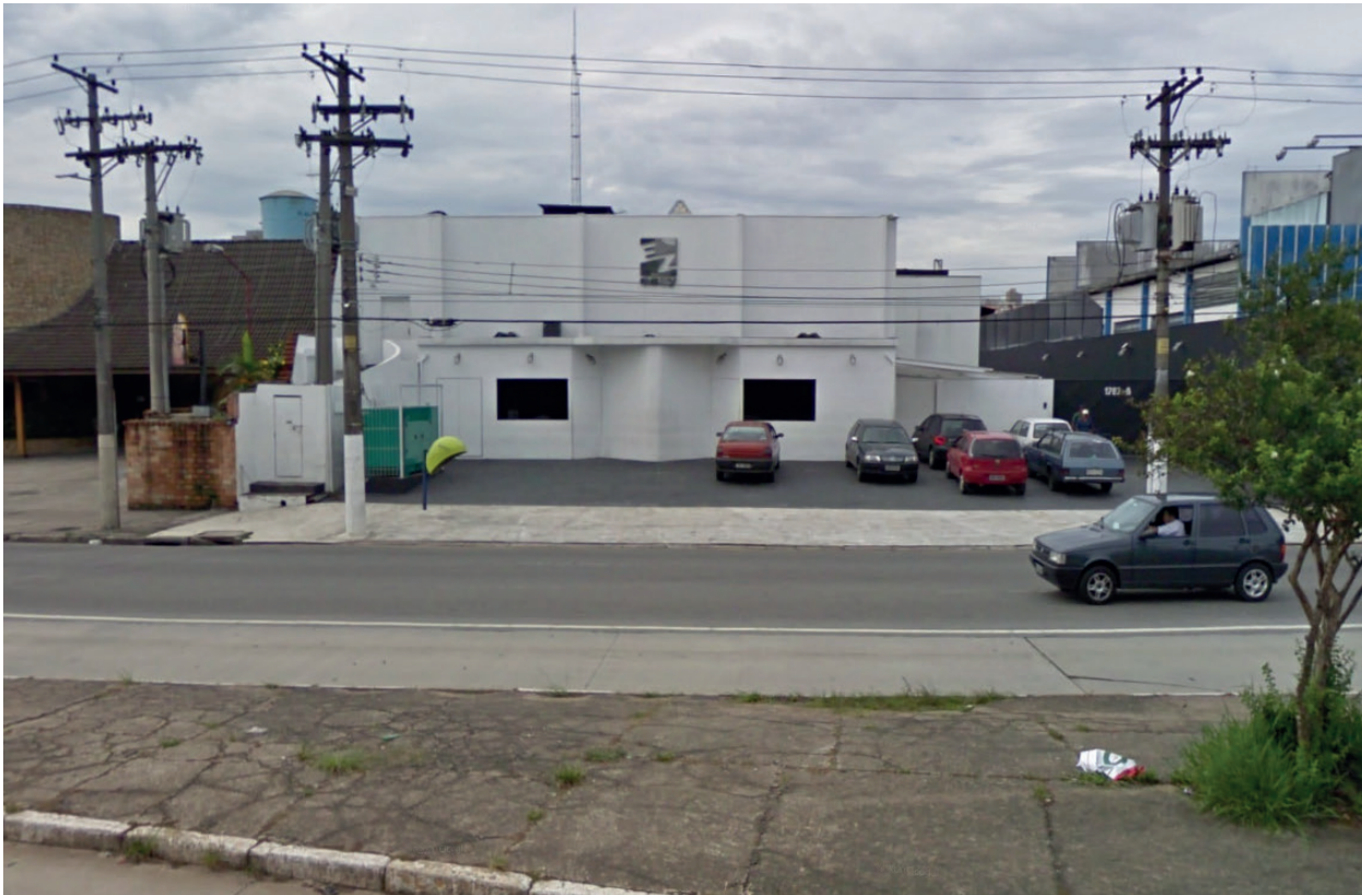
FIGURAS 9 e 10 Imóveis potencialmente NU, tipologia de edificação “Edificações Térreas”* (Belém e Barra Funda) *Exceto casa e galpão.
