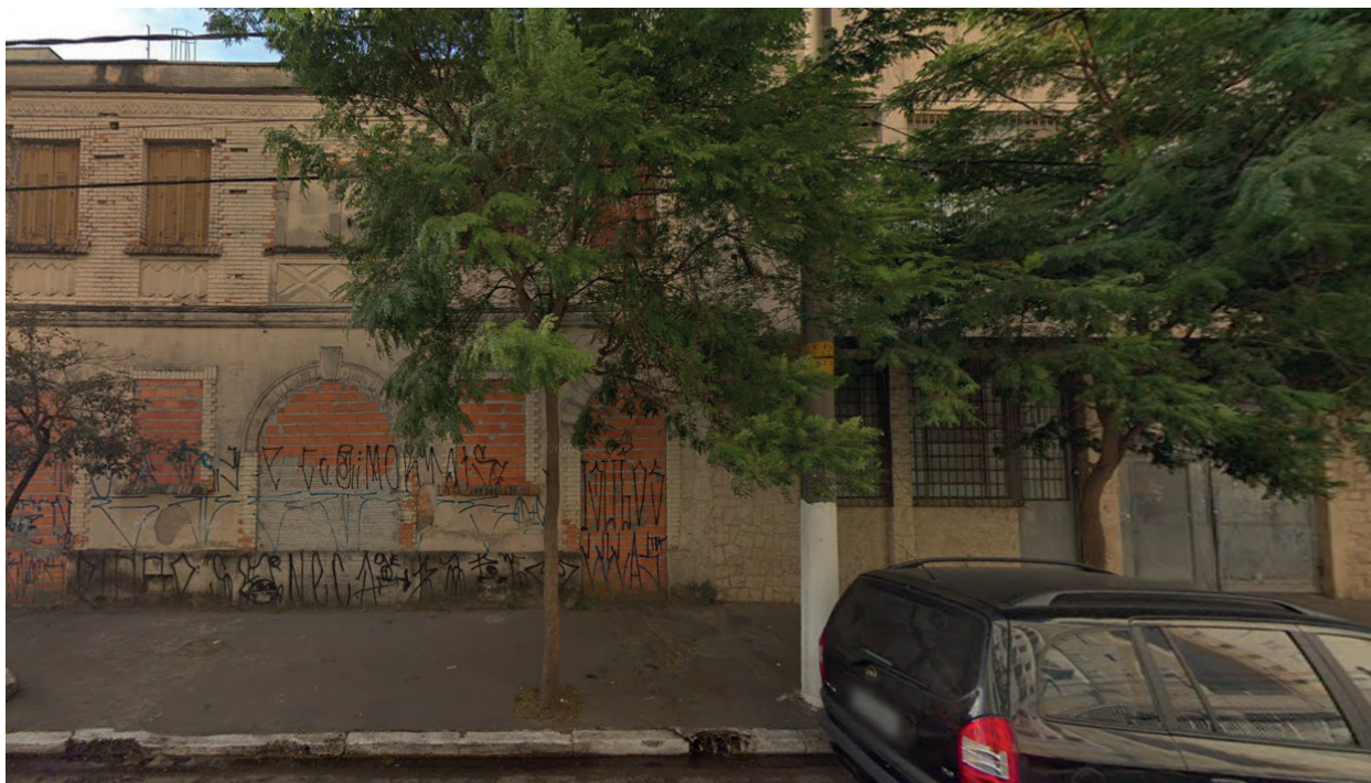
NU0062 – Imóvel no Cambuci com acessos lacrados
