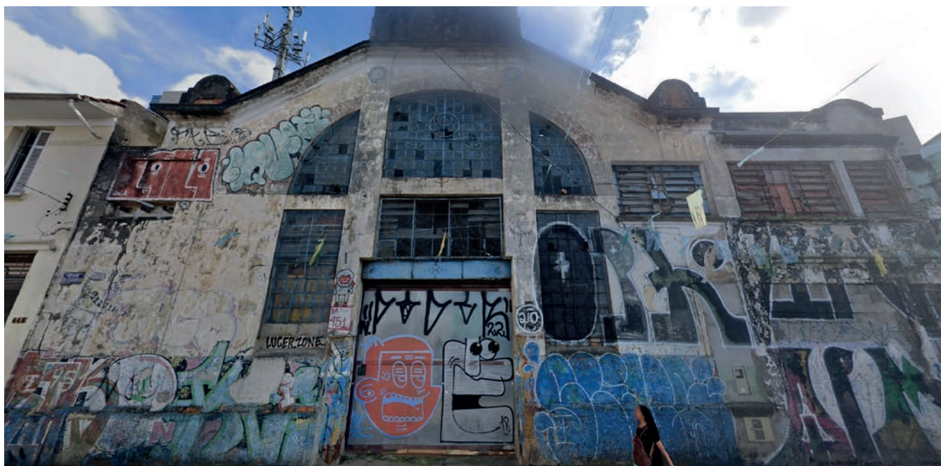
FIGURA 6 Imóvel potencialmente Não Utilizado com janelas quebradas, lacradas ou com fechamento provisório (NU0094).
