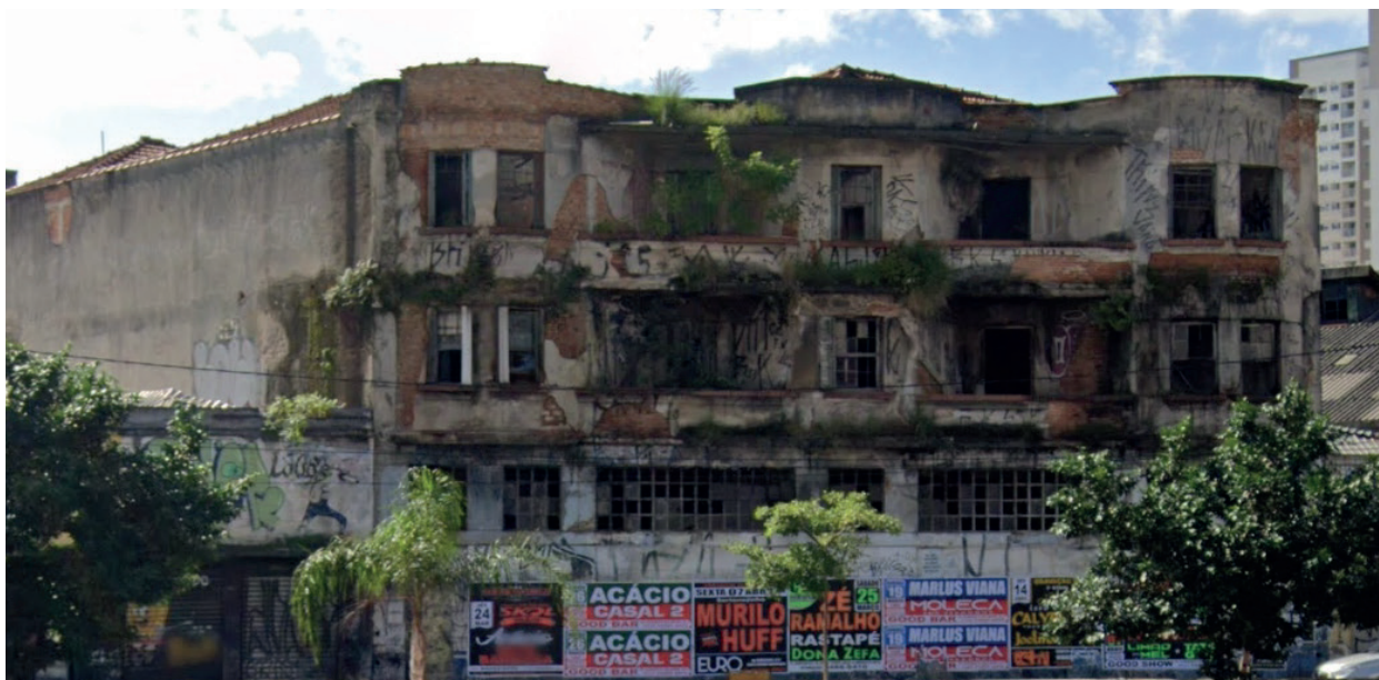
NU0028 – Imóvel no Brás em mau estado de conservação, com acessos lacrados e janelas quebradas, lacradas ou com fechamento provisório
