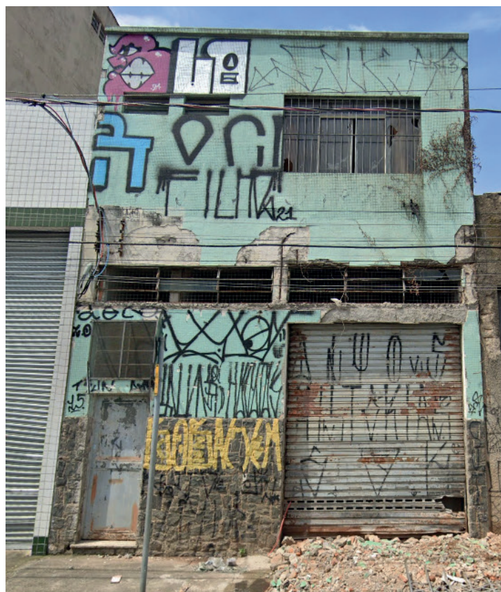
FIGURA 5 Imóvel potencialmente Não Utilizado com acessos lacrados (NU0720).
