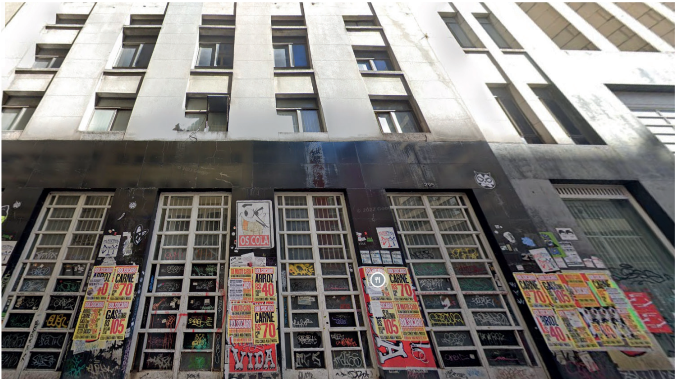
FIGURA 4 Imóvel potencialmente Não Utilizado com acessos lacrados (NUo124).
