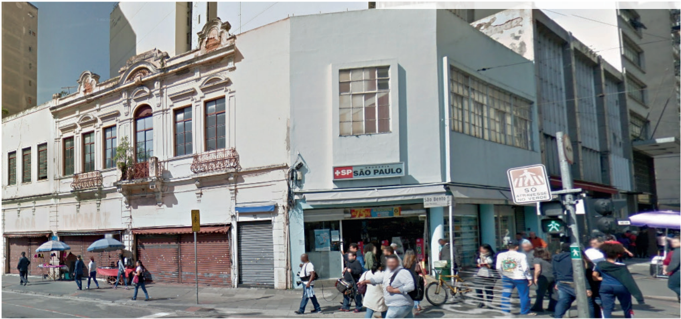
FIGURA 4 Imóvel potencialmente Não Utilizado (NU0026).
