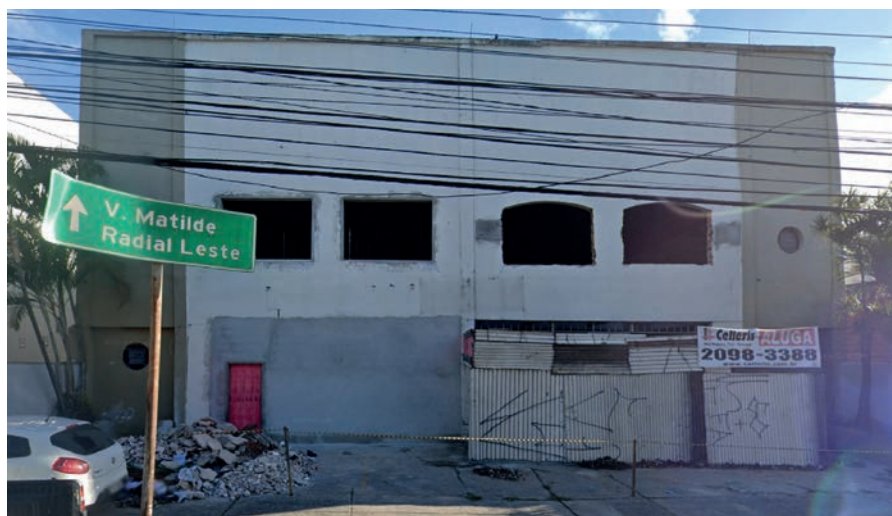
FIGURA 5 Imóvel potencialmente Não Utilizado com acessos lacrados (NU1143).
