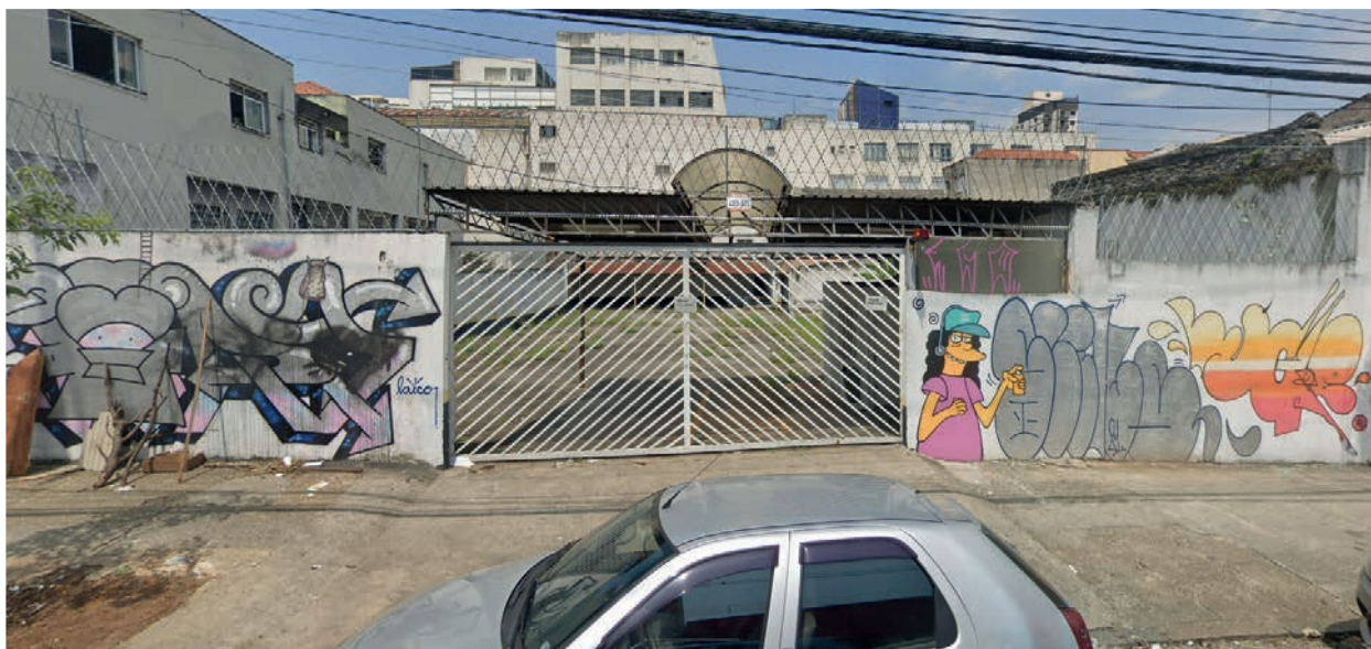
FIGURAS 3 e 4 Imóveis potencialmente NE e SU, respectivamente (Bela Vista e Santa Cecília)
