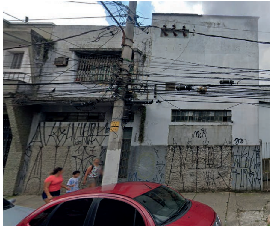
FIGURA 6 Imóvel potencialmente Não Utilizado com acessos lacrados (NU0045).
