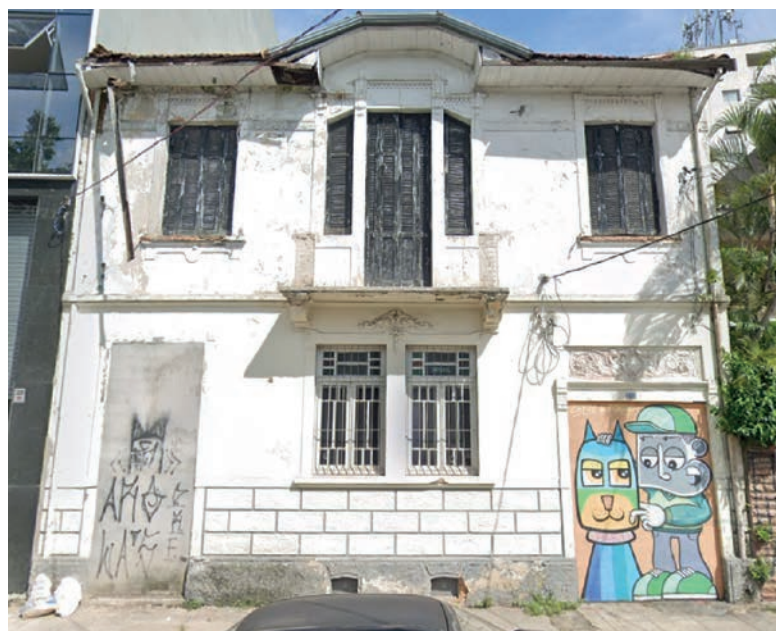
FIGURA 5 Imóvel potencialmente Não Utilizado com acessos lacrados (NU0275).
