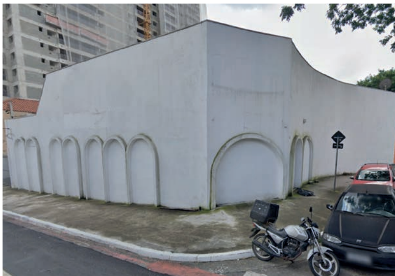
FIGURA 4 Imóvel potencialmente Não Utilizado com acessos lacrados (NU0770).
