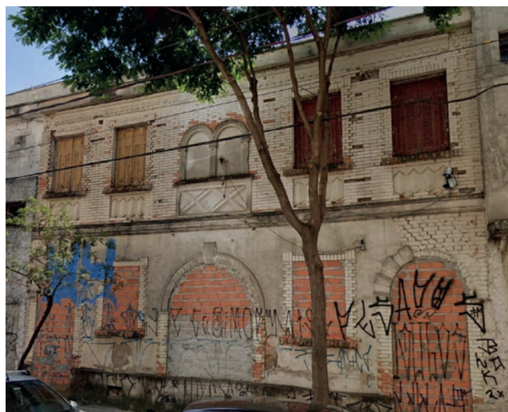
FIGURA 4 Imóvel potencialmente Não Utilizado com acessos lacrados (NU062).
