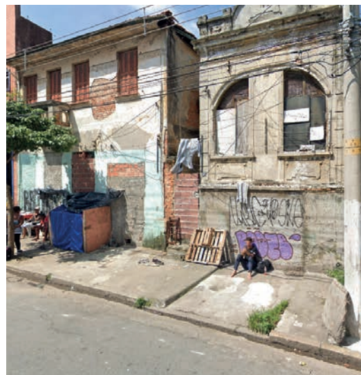
FIGURA 5 Imóvel potencialmente Não Utilizado com acessos lacrados (NU0653).
