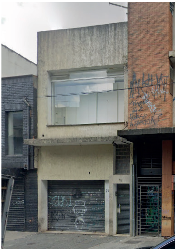
FIGURA 3 Imóvel potencialmente Não Utilizado na tipologia de uso predominante do distrito (NU2156).
