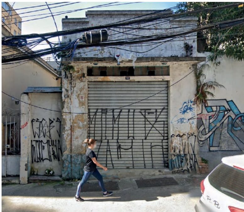
FIGURA 6 Imóvel potencialmente Não Utilizado com janelas quebradas, lacradas ou com fechamento provisório (NU0181).
