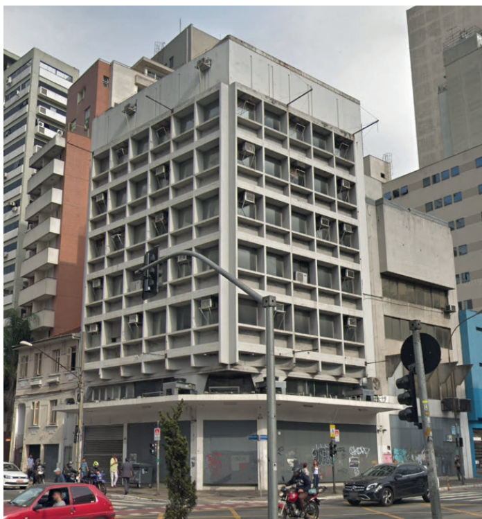
FIGURAS 8 a 9 Imóveis NU “não condominiais” notificados: edifícios nas Ruas Floriano Peixoto e Consolação, na Subprefeitura Sé
