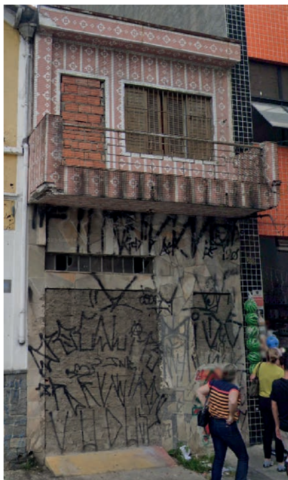
FIGURA 4 Imóvel potencialmente Não Utilizado com acessos lacrados (NU0352).
