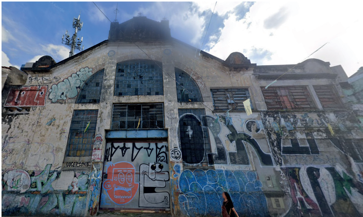
FIGURAS 7 e 8 Imóveis potencialmente NU, tipologia de edificação “Galpão” (Brás e Sé)
