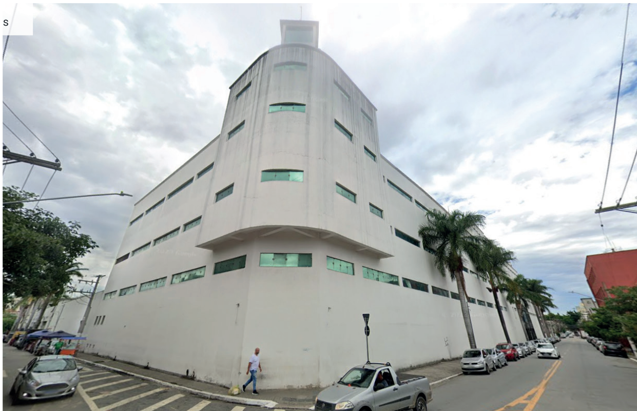
FIGURA 15 Imóvel potencialmente NU, tipologia de edificação “Térreo + 3 Pavimentos Tipo” (Belém)
