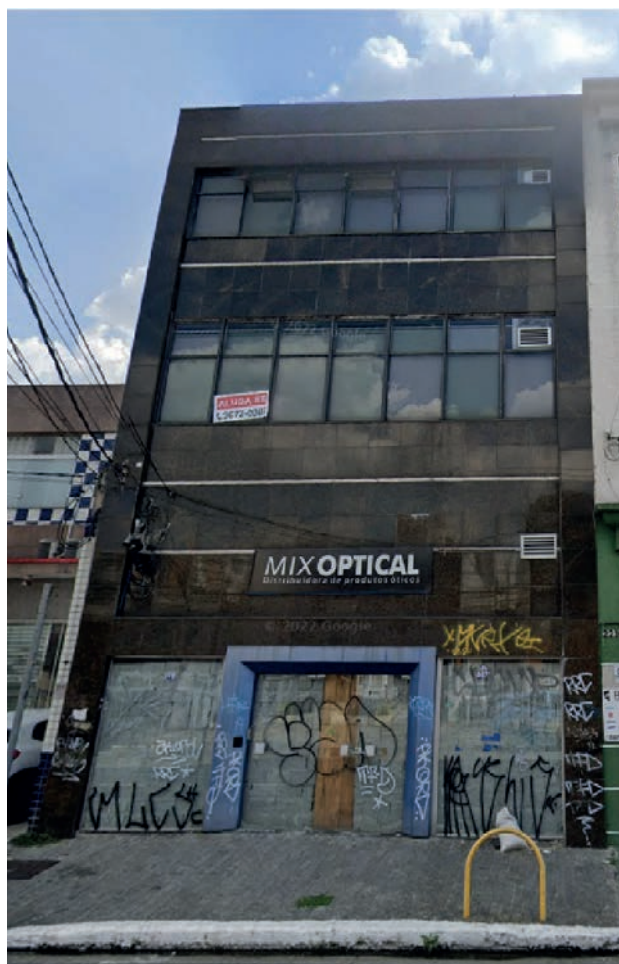
FIGURA 7 Imóvel potencialmente Não Utilizado com acessos lacrados (NU0847).
