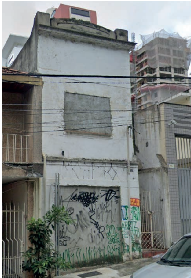
FIGURA 5 Imóvel potencialmente Não Utilizado com acessos lacrados (NU0206).
