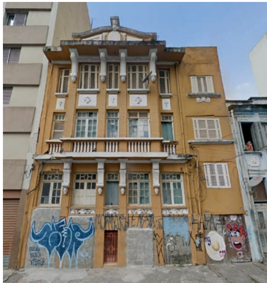
FIGURA 4 Imóvel potencialmente Não Utilizado com acessos lacrados (NU0117).
