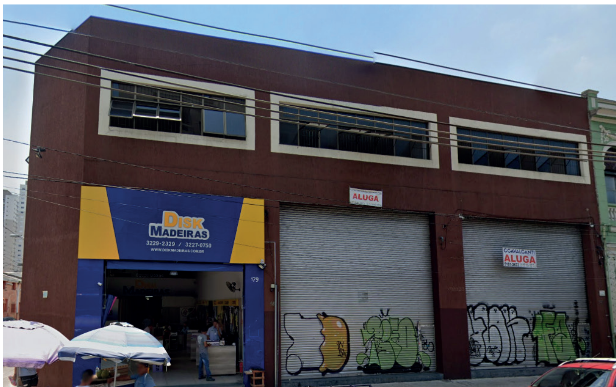
FIGURA 4 Exemplo de imóvel parcialmente ocupado, classificado como potencial Não Utilizado
