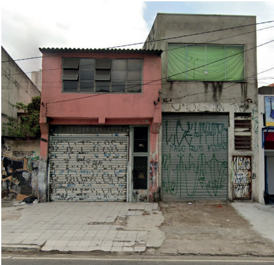
FIGURA 9 Imóvel potencialmente Não Utilizado com janelas quebradas, lacradas ou com fechamento provisório (NU0988).
