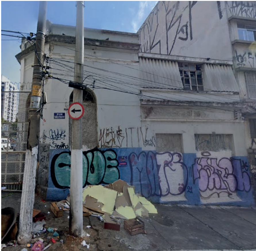
FIGURA 4 Imóvel potencialmente Não Utilizado com acessos lacrados (NU0118).
