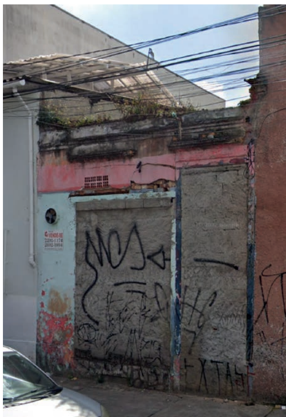
FIGURA 7 Imóvel potencialmente Não Utilizado com acessos lacrados (NUo465).
