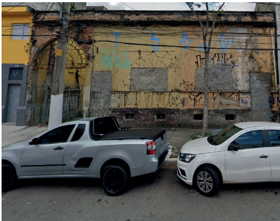
FIGURA 4 Imóvel potencialmente Não Utilizado com acessos lacrados (NU2048).
