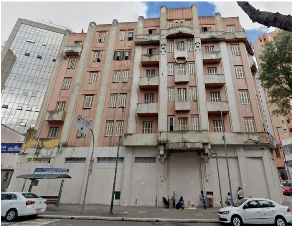
FIGURA 4 Imóvel potencialmente Não Utilizado com acessos lacrados (NU1198).
