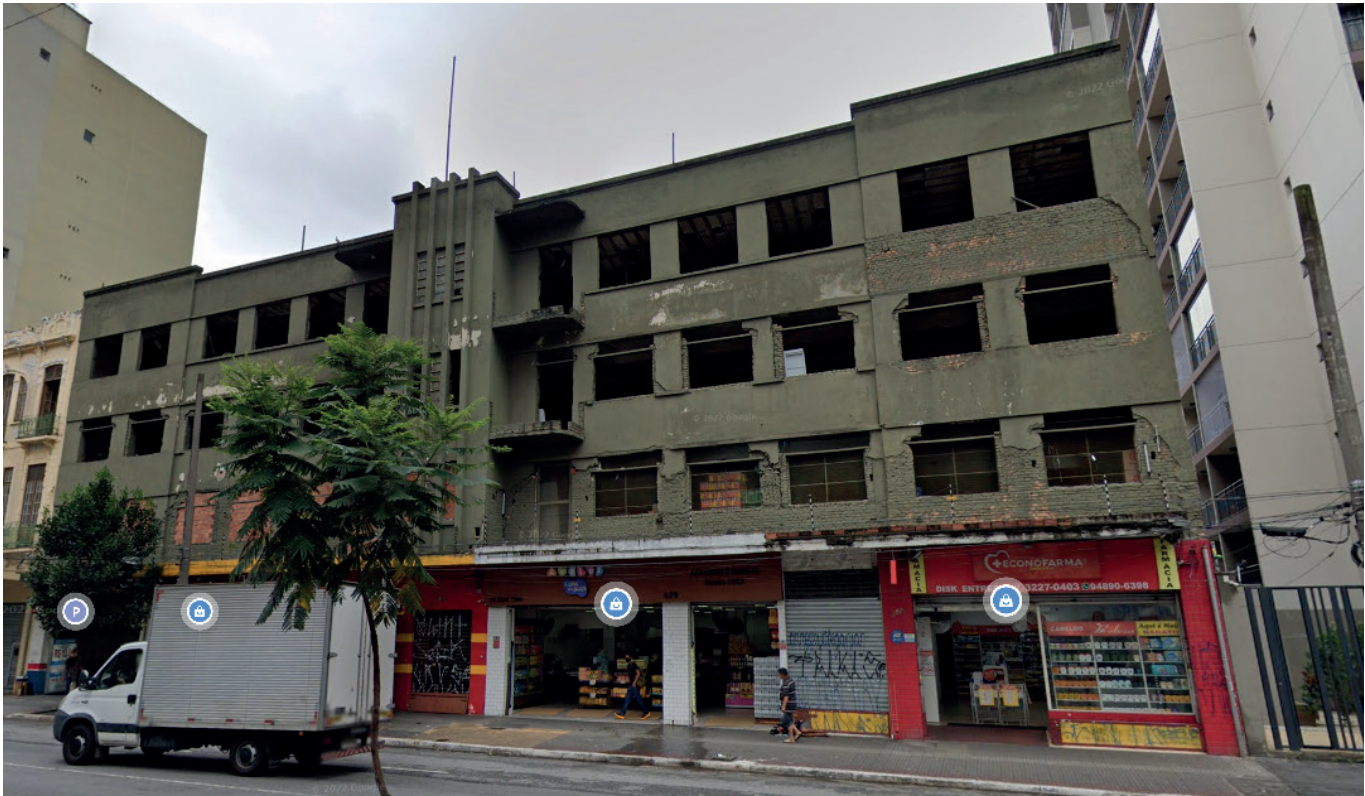
FIGURA 5 Imóvel potencialmente Não Utilizado com janelas quebradas, lacradas ou com fechamento provisório (NU0024).
