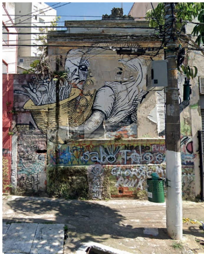
FIGURA 5 Imóvel potencialmente Não Utilizado com acessos lacrados (NU0132).
