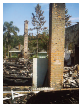
Casa de Engenheiro da rua Rodrigues Alves após o incêndio. Foto: Vanessa Figueiredo, 18 dez. 2005.
