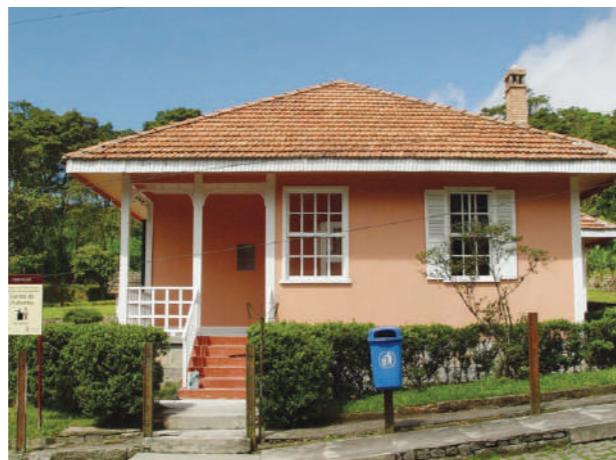
Centro de Visitantes do Parque em casa de engenheiro. Foto: Eduardo Pin, 2005.
