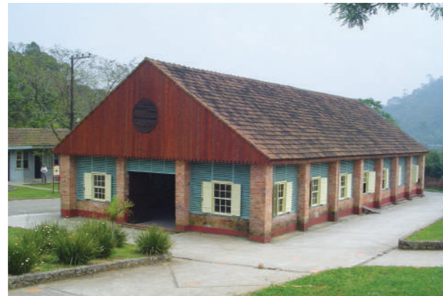
Antigo Mercado – depois do restauro. Foto: PMSA/Julio Bastos, 2005.
