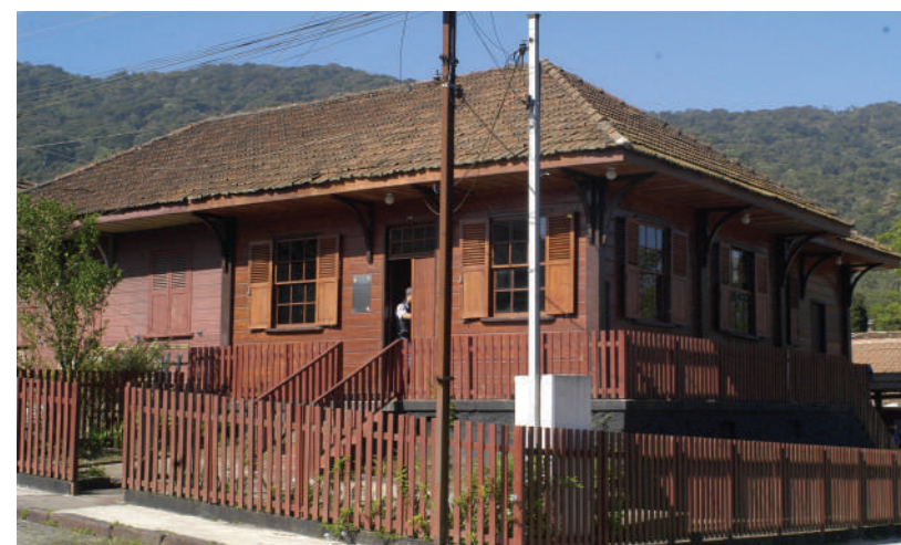
Casa “Typo B”: fachada com duas janelas e uma porta e mãos francesas arredondadas. Foto: Julio Bastos, 2008.
