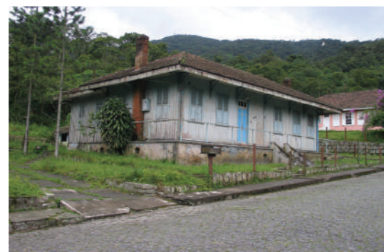
Casa de Engenheiro da rua Rodrigues Alves antes do incêndio. Foto: Luis Saia/IPHAN, 7 dez. 2005.
