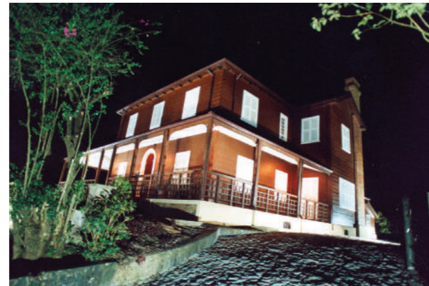
Castelinho depois do restauro, com a fachada sudoeste reconstruída e iluminação. Foto: PMSA/Julio Bastos, 2006.
