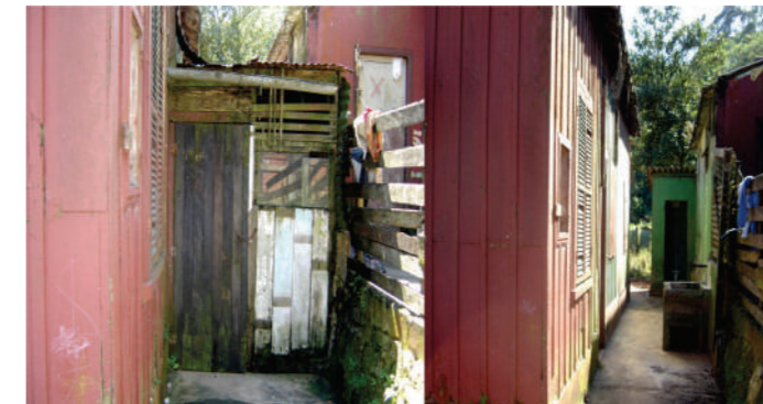
Retirada de anexos precários (antes e depois). Fotos: Vanessa Figueiredo, 2006.
