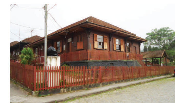
Restauo das Casas Tipo B para a sede do corpo de bombeiros. Foto: Vanessa Figueiredo, 2013.
