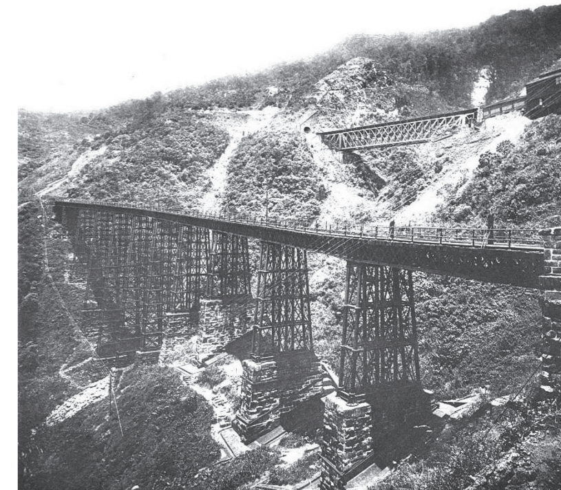
Ponte metálica da Grota Funda (4º Patamar). Final do século XIX. Acervo SPR/RFFSA/IPHAN.
