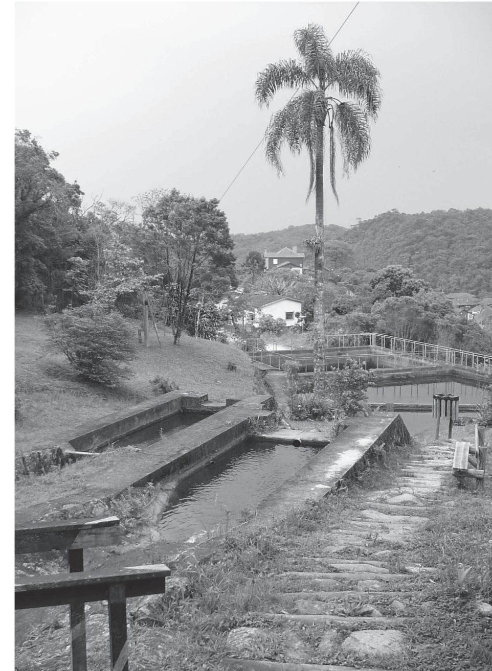
Reservatório D' água construído pela SPR - São Paulo Railway no Parque Nascentes. Foto:PMSA/Julio Bastos,2005.
