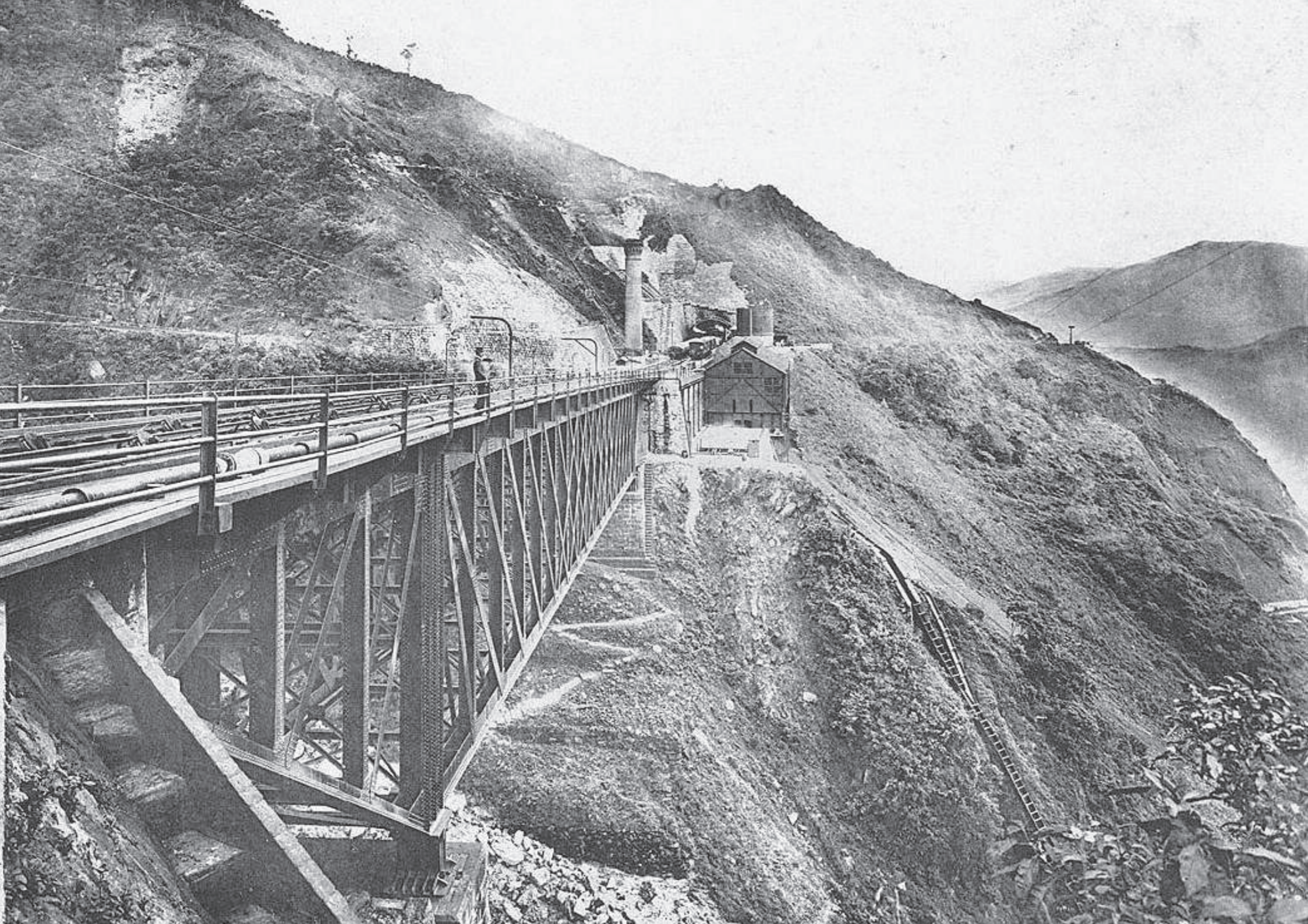
4º Patamar do sistema funicular com viaduto da grotta funda, final do século XIX. Acervo: SPR/RFFSA/IPHAN.
