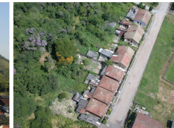
Área de Transição do Parque: ocupações ao fundo do lote adentrando a área do Parque Nascentes. Fonte: PMSA, 2006. Foto: LUME FAUUSP.
