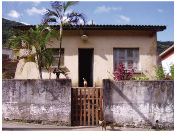
Casa em alvenaria isolada. Foto: Vanessa Figueiredo, 2006.
