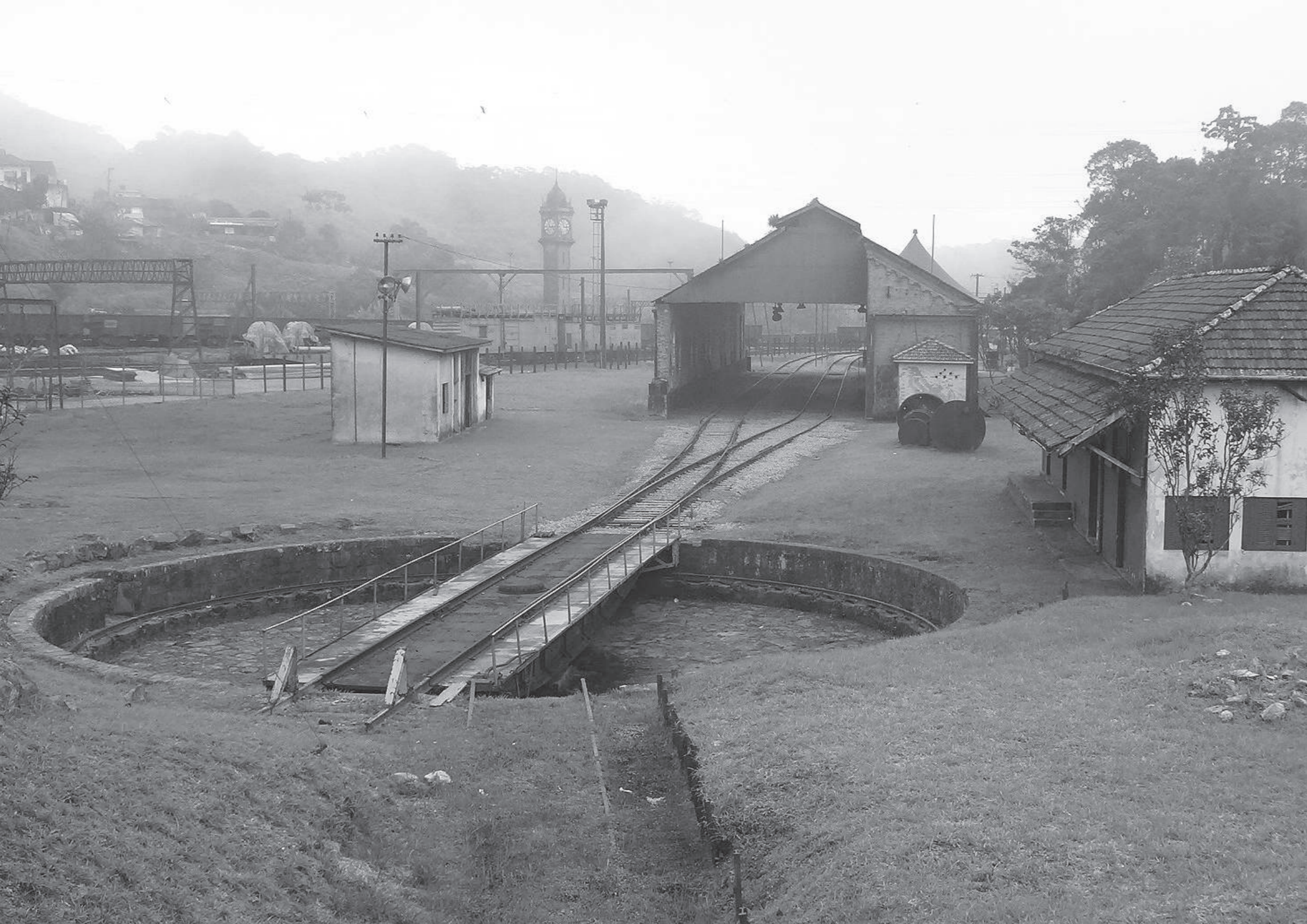
Viradouro para manobra de trens no pátio de Paranapiacaba. Foto: Ronaldo André Rodrigues, 2012.
