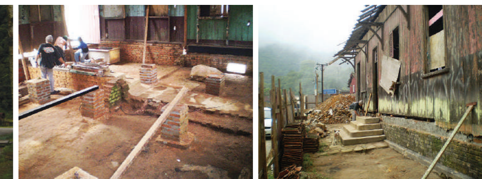
Antiga Padaria durante o restauro: sem soalho e escada descoberta sobre o embasamento posterior. Foto: Gilson Lima, 2008.
