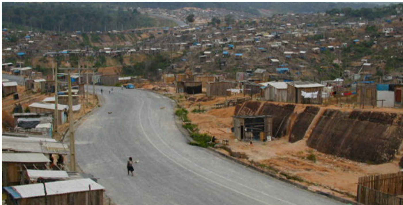
Figura 7. Assentamento Grande Vitória, 2004
