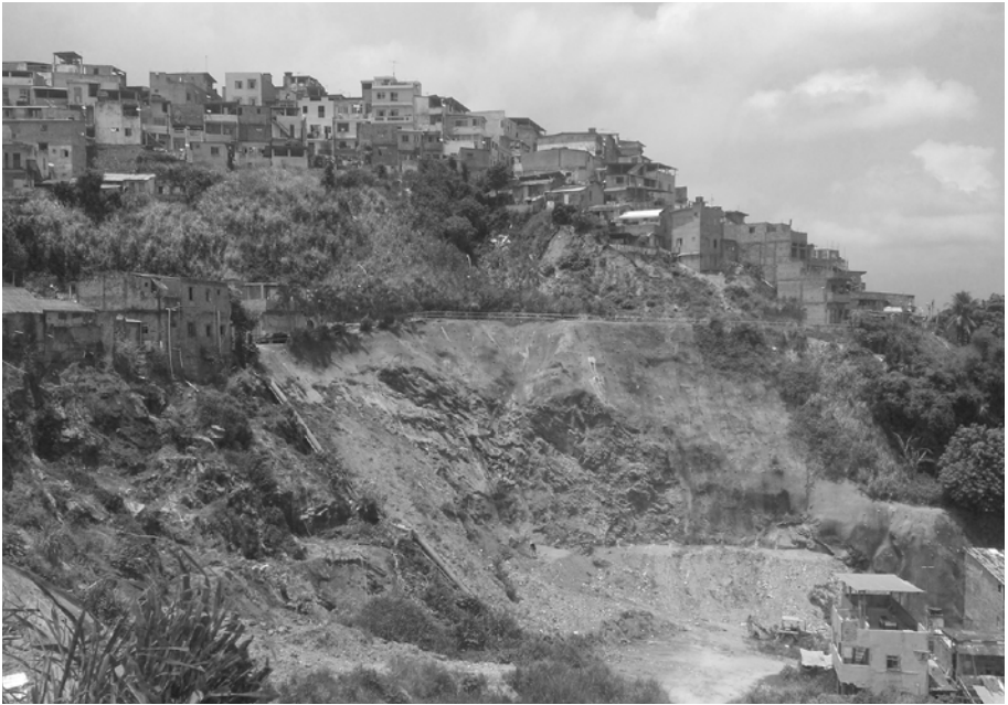
Foto 4 – Obra de contenção de encosta do PAC no Alto do Bom Viver
