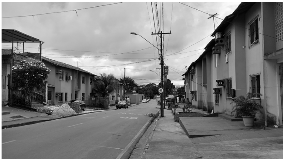
Fotos 13 - Unidades Habitacionais construídos na Comunidade Taboquinha, em Belém
