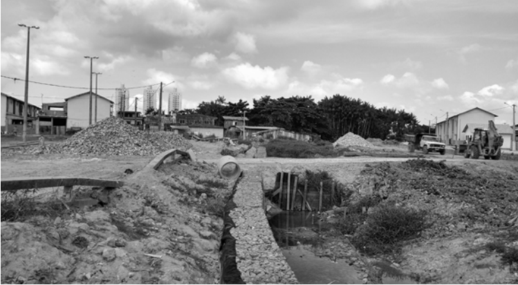
Foto 12 - Gabião de contenção da área de APP na Comunidade Taboquinha, em Belém
