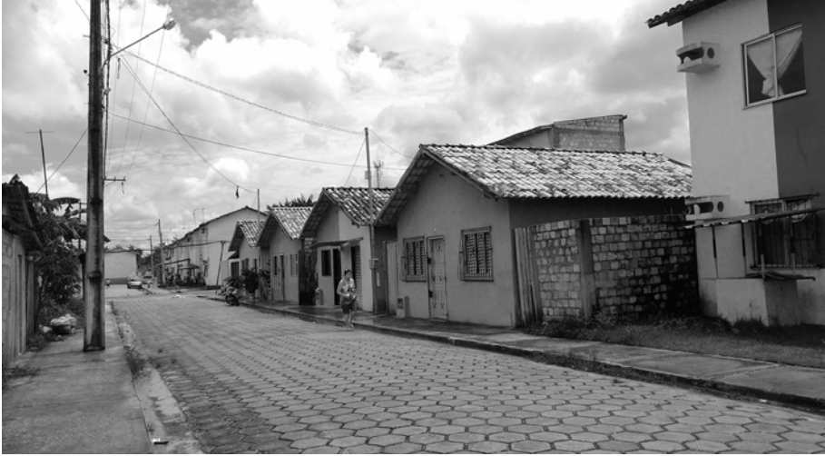
Fotos 14 - Unidades Habitacionais construídos na Comunidade Taboquinha, em Belém
