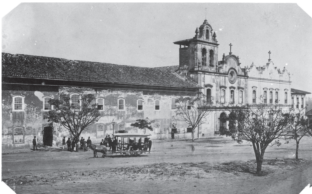
Figura 5 – Convento de São Francisco, Igreja de São Francisco e Igreja da Ordem Terceira do Pai Seráfico. 1874. Militão Augusto de Azevedo. Acervo Fotográfico do Museu da Cidade de São Paulo.
