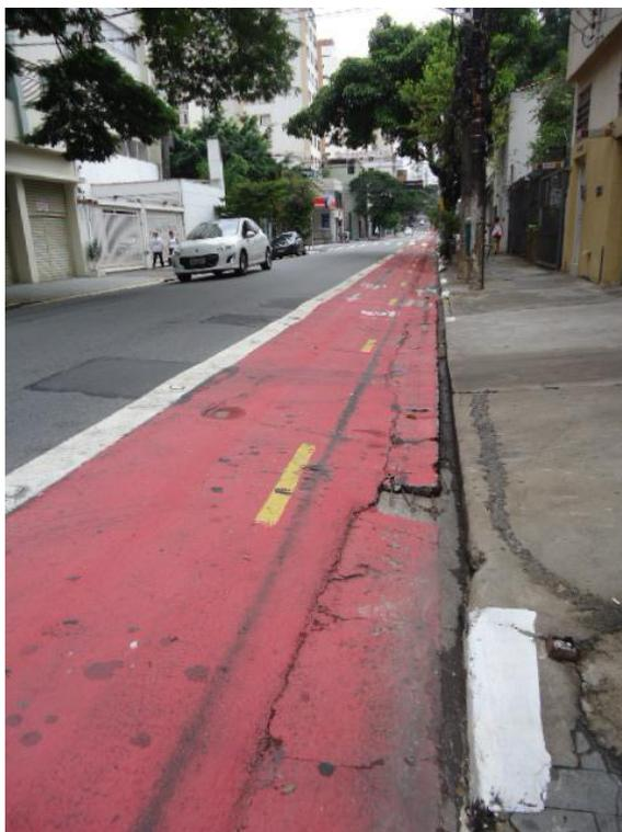
Vista da ciclofaixa da R. Artur de Azevedo, proximidade do nº 1.439, com superfície irregular e com faixa lindeira à guia obstruída por rampa de concreto.
