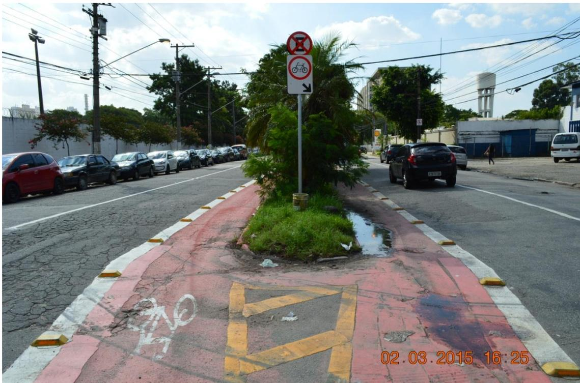
Vista da ciclofaixa da Av. Torres de Oliveira, proximidade do nº 435, com empoçamento de água, obstruído por ramagens de árvores, depressões e com pintura desgastada.
