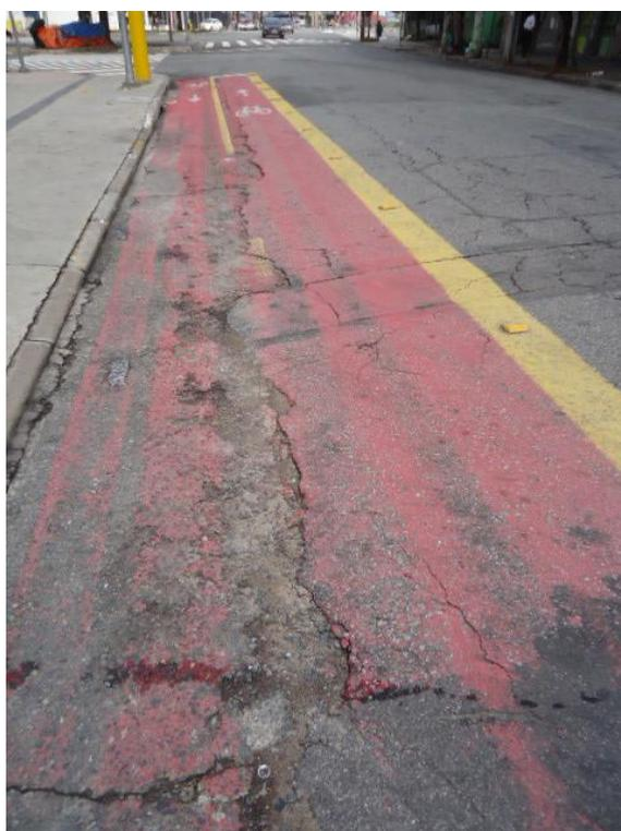
Vista do trecho final da ciclofaixa da R. dos Pinheiros, proximidade da Av. Brig. Faria Lima (Alt. nº1.518), com revestimento em acentuado processo de desagregação.
