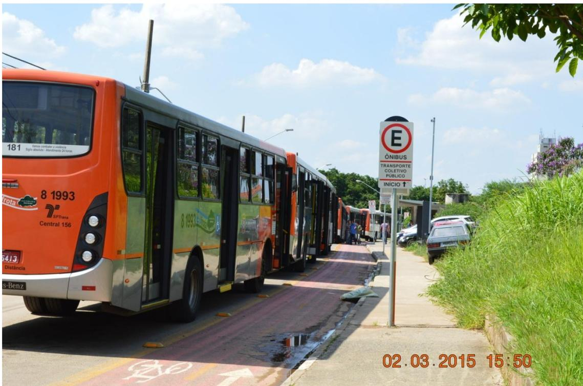
Vista da ciclofaixa/ciclovia da Av. Escola Politécnica, altura do nº 5.165, com pintura apagada, com empoçamento de água e ao lado do ponto final de ônibus.
